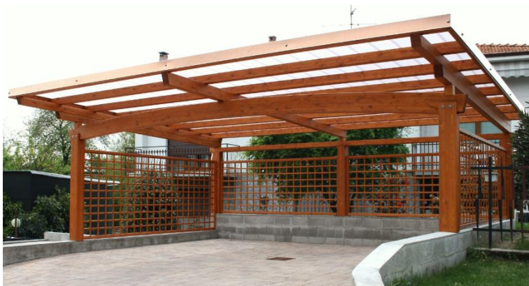
Slika 2 - Primjer drvene nadstrešnice [2]
