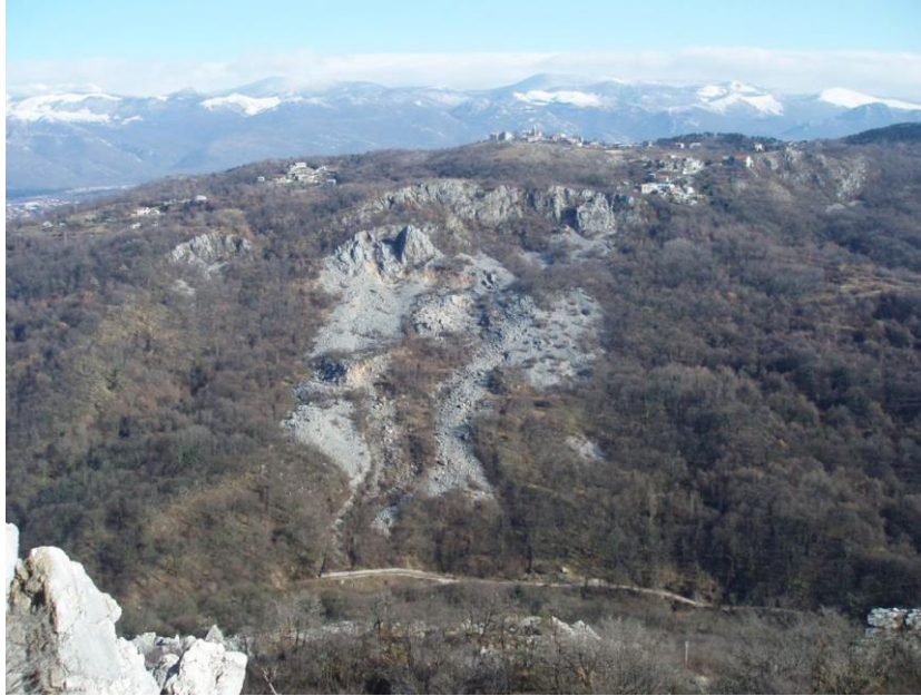
Slika 22. Klizište Grohovo, Rijeka, Hrvatska [20]
