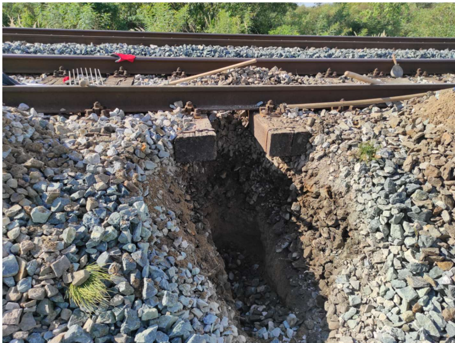
Slika 8. Sondažna jama SJ-15 na stacionaži 224+100 (Geotech d.o.o)
