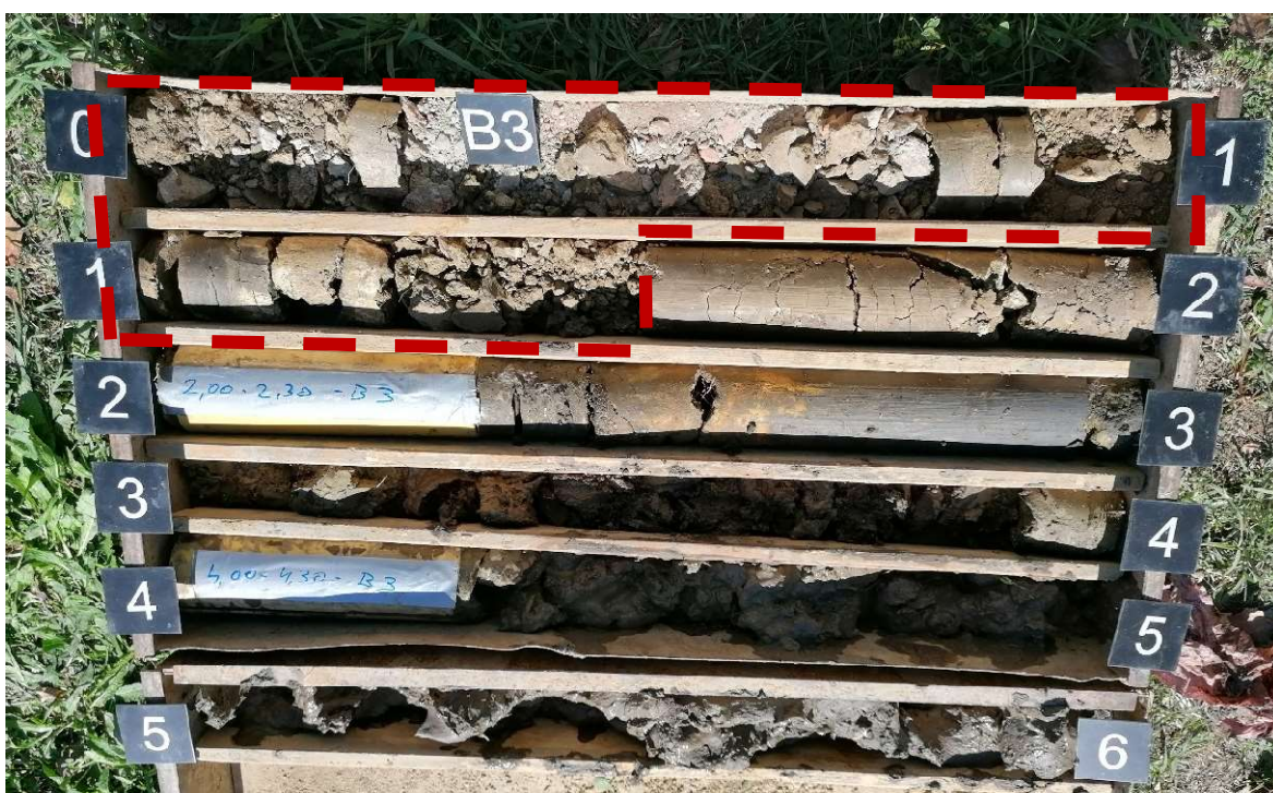
Slika 18. Naslage geotehničke jedinice 1 - Nabačaja u sklopu bušotine B-3 (Geotech d.o.o.)
