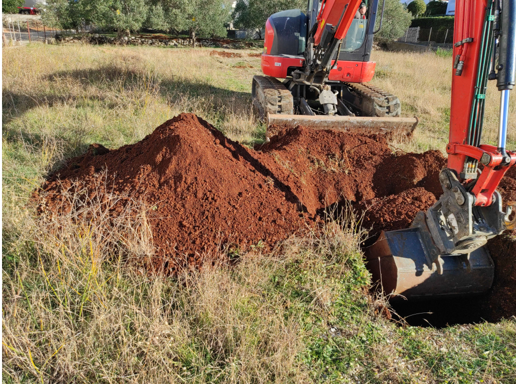
Slika 2. Strojni iskop sondažne jame
