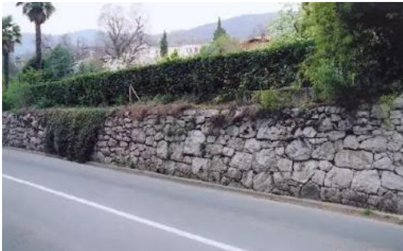
Slika 9. Primjer potpornog zida rađenog od suhozida (foto: Renar d.o.o. i Neuron d.o.o, 2004.)
