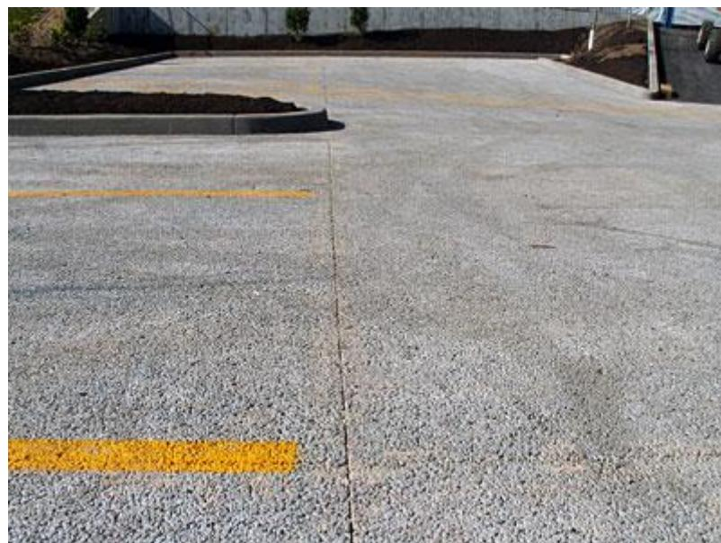
Slika 2: Parkiralište od procjednog betona [6]
