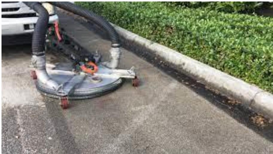
Slika 5: Čišćenje procjednog betona [19]
