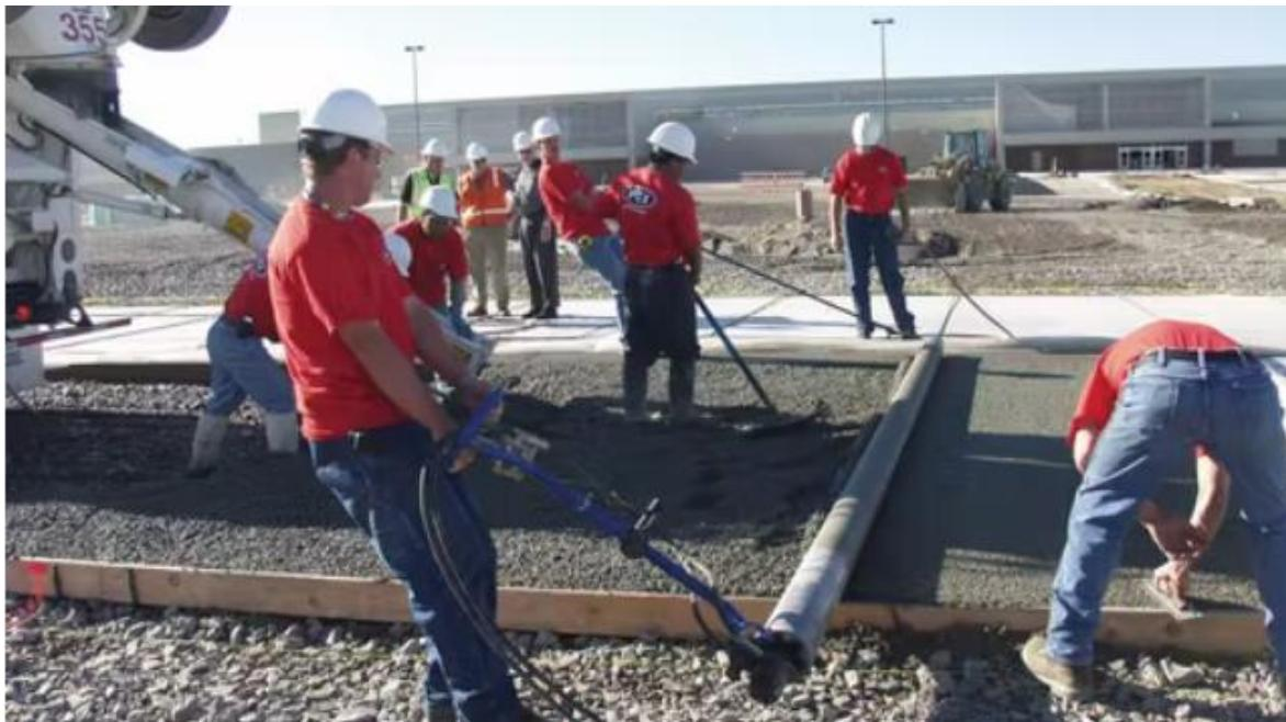
Slika 6: Rasprostiranje procjednog betona [20]
