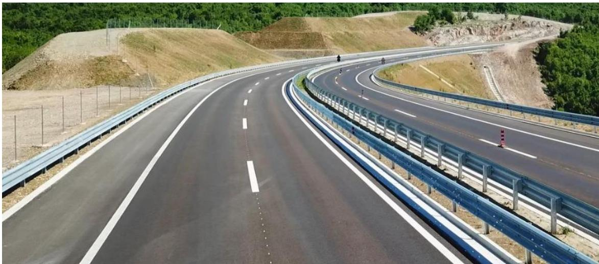
Slika 23. Primjer zaštitne odbojne ograde na autocesti [19]
