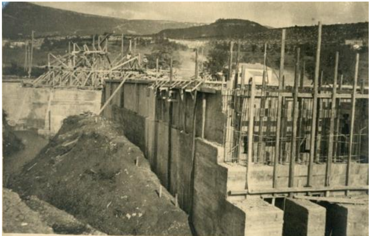
Slika 46: Postavljanje oplata za kupolu [6]
