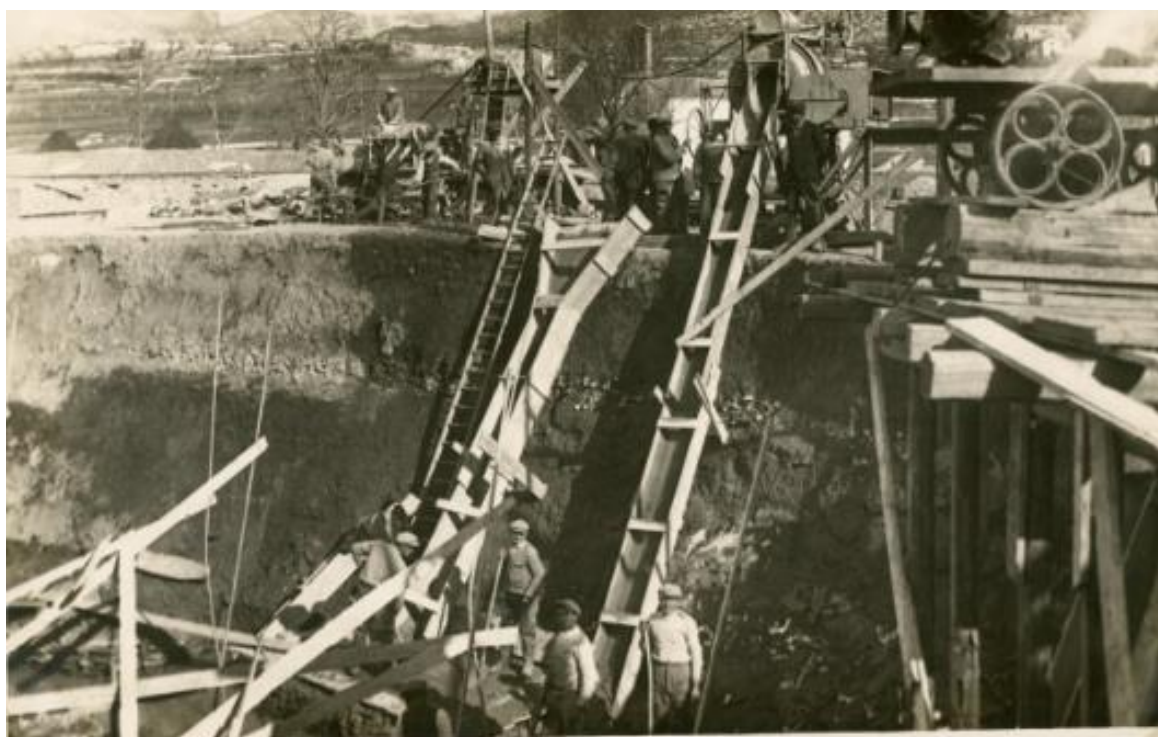
Slika 40: Iskopi za temelje kupole [6]
