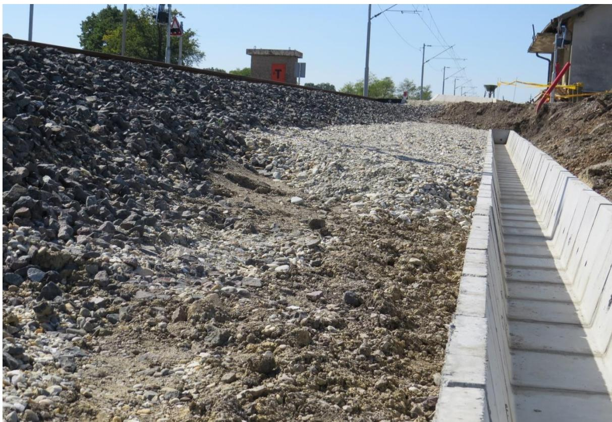
Slika 24. Ugradnja gotovih betonskih kanalica tipa 2, Pružne građevine
