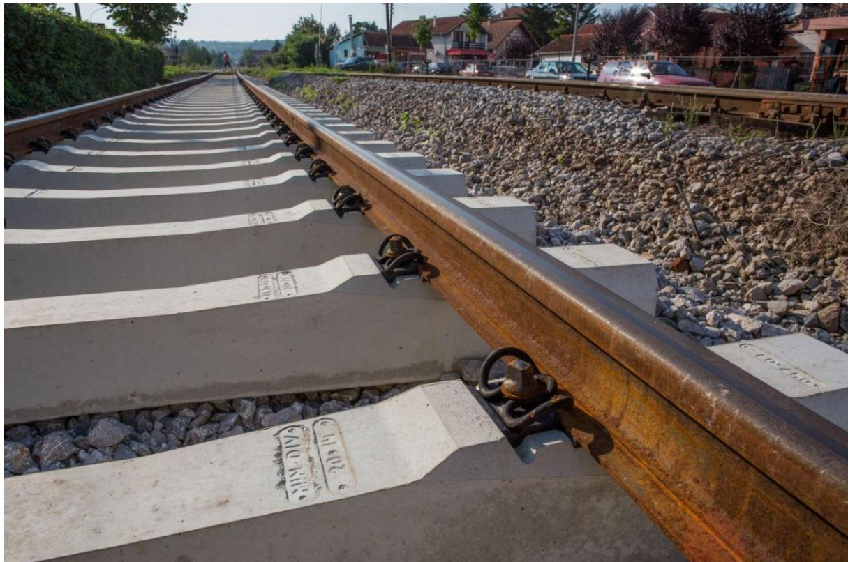
Slika 6. Admirano betonski željeznički pragovi [14]
