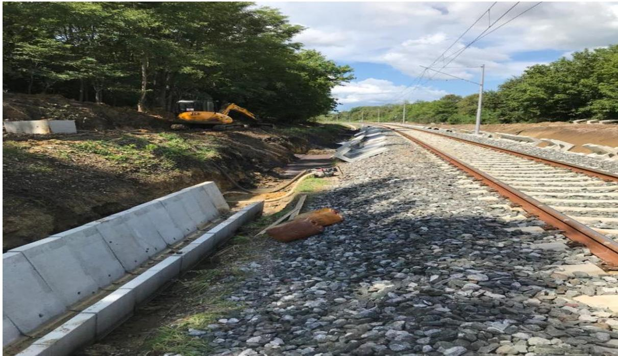
Slika 21. Ugradnja gotovih betonskih odvodnih kanalica tipa 1, Pružne građevine
