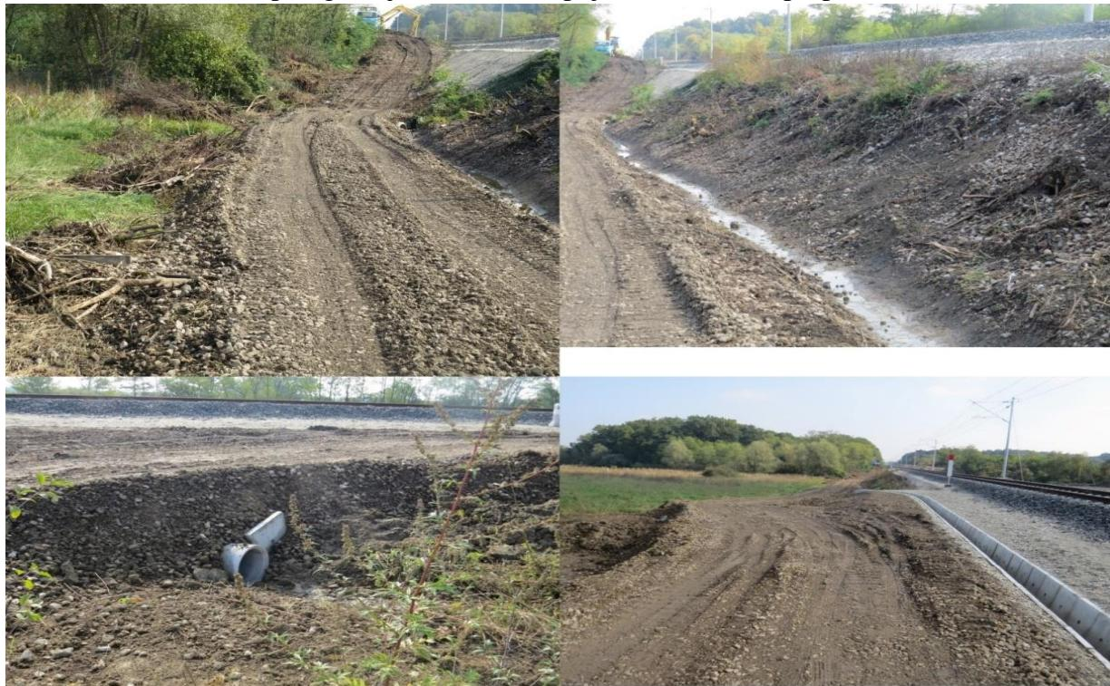
**Slika 25. Odvodnja sa spojem na betonski propust, Pružne građevine**
