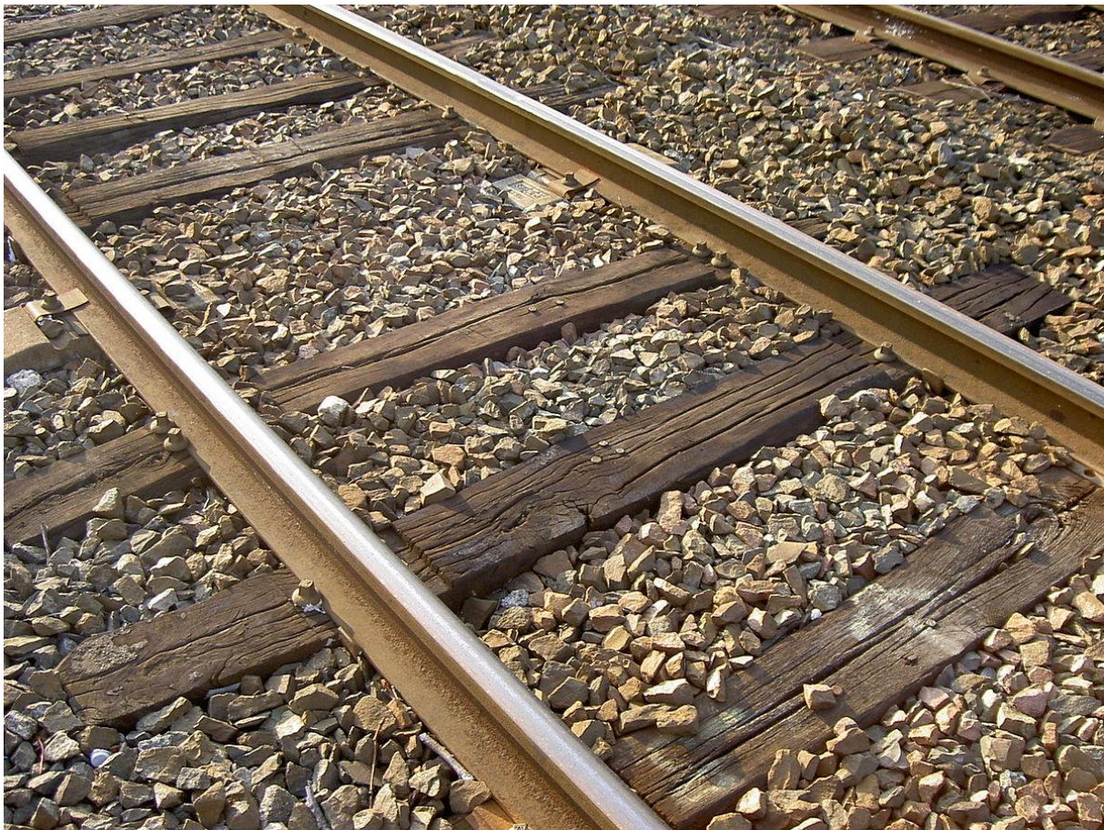
Slika 4. Željeznički drveni pragovi [13]
