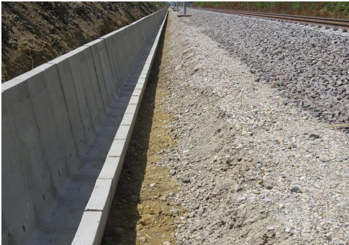
Slika 23. Ugradnja gotovih betonskih kanalica tipa 1, Pružne građevine
