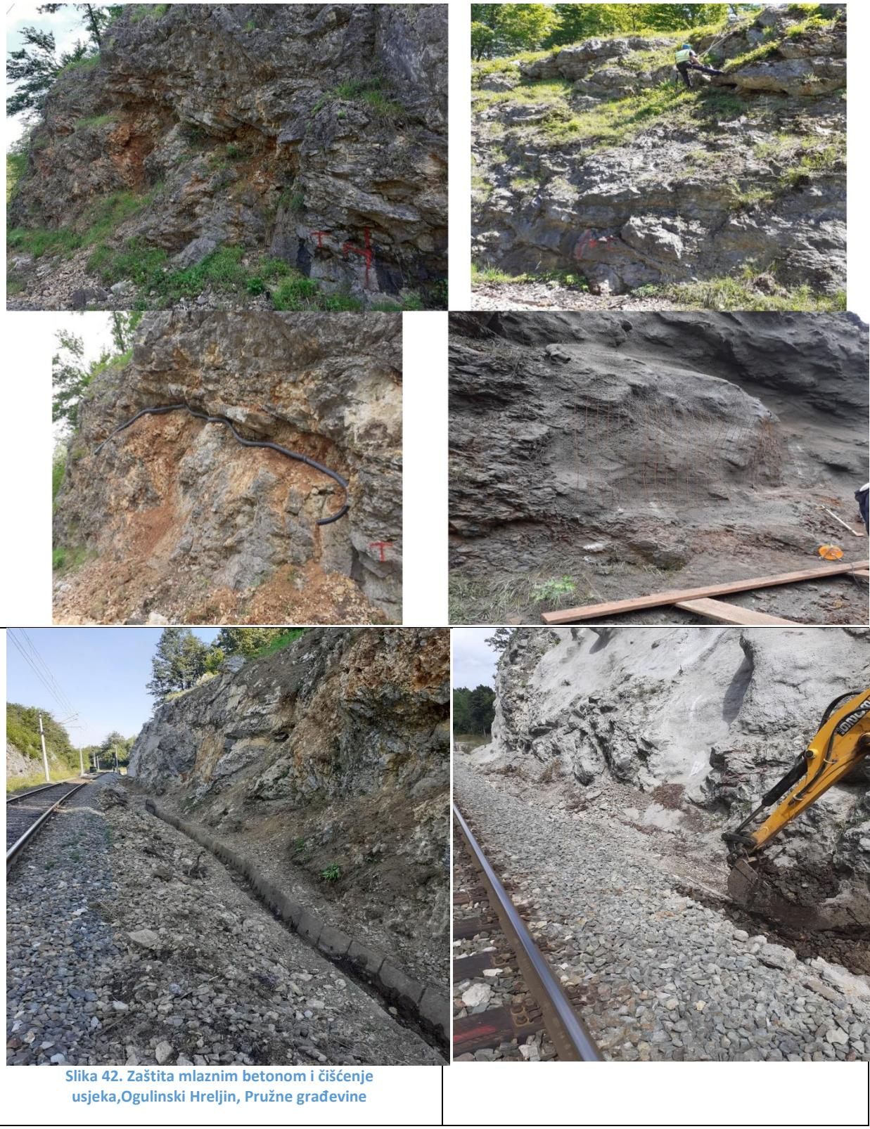
Slika 42. Zaštita mlaznim betonom i čišćenje usjeka, Ogulinski Hreljin, Pružne građevine
