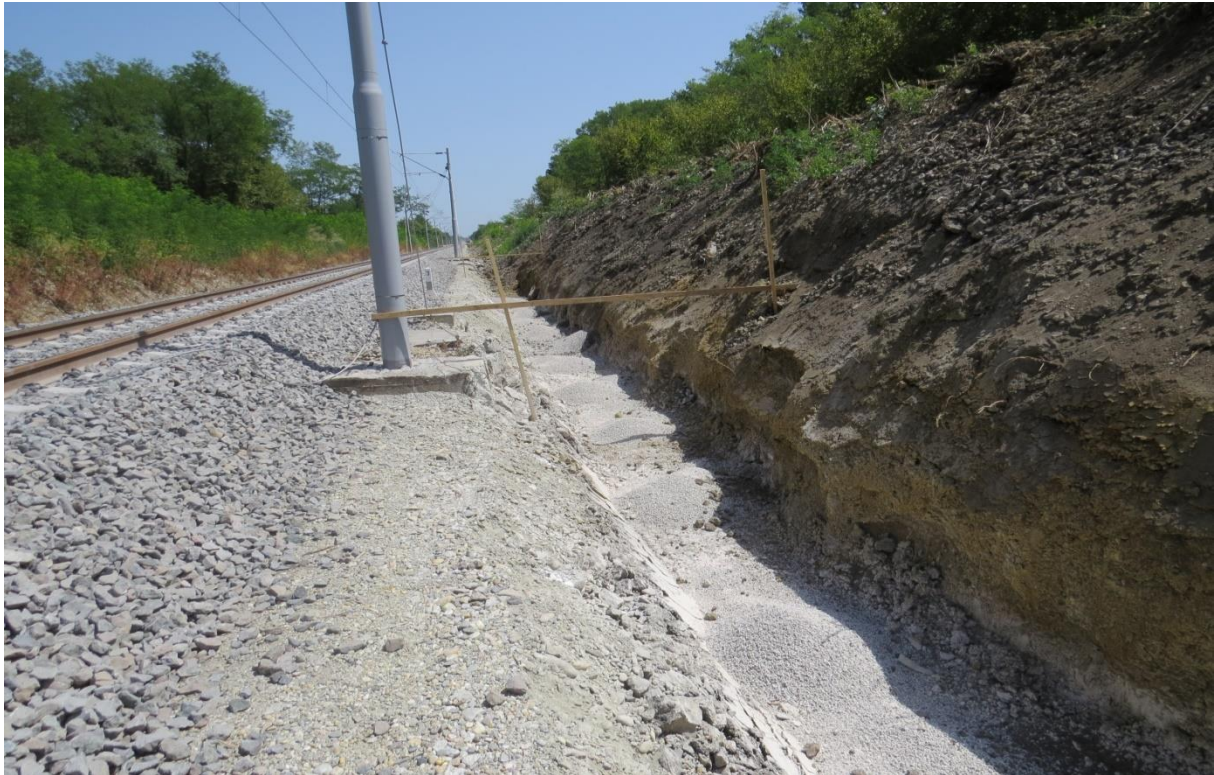
Slika 19. Priprema kanala za podložni beton, dionica pruge Sisak-Sunja, Pružne građevine
