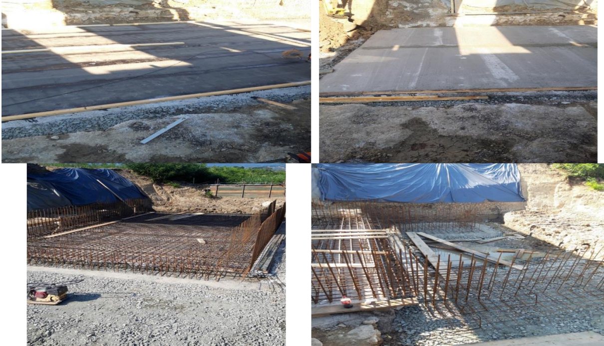
Slika 48. Armiranje donje ploče, Staro Petrovo Selo, Pružne građevine
