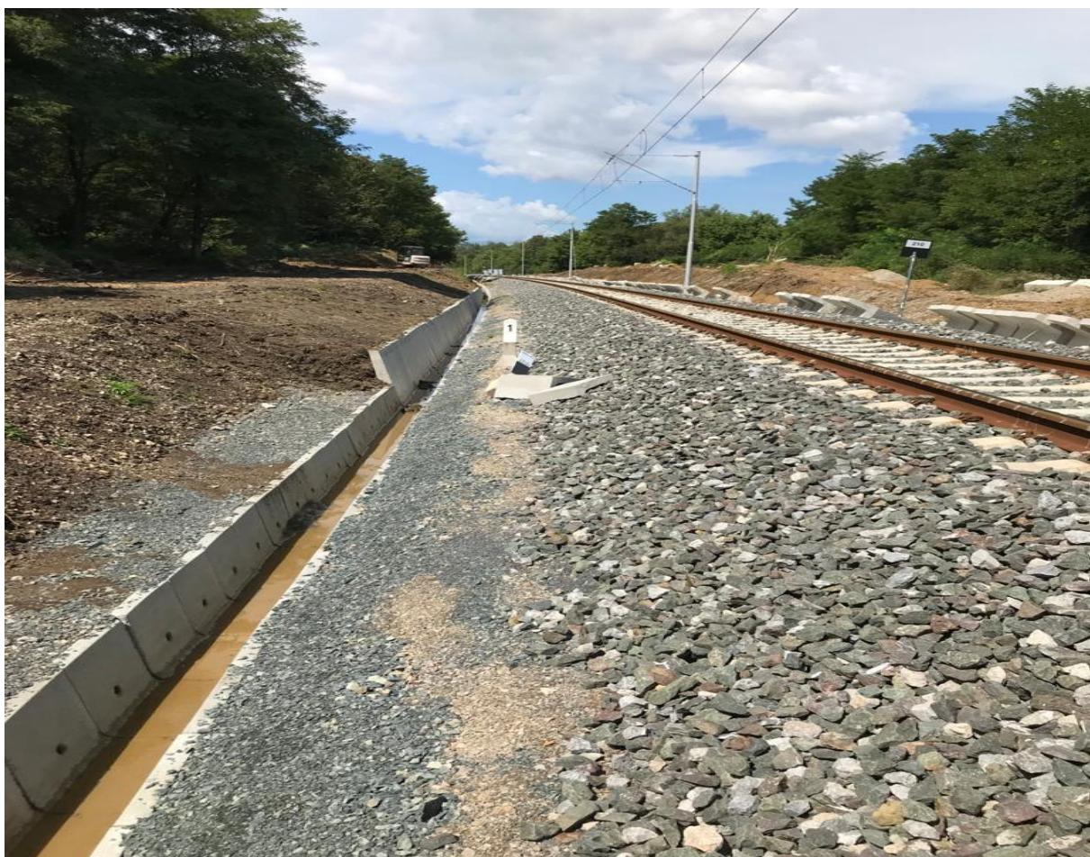
Slika 22. Ugradnja gotovih betonskih odvodnih kanalica tipa 1 i tipa 2, Pružne građevine
