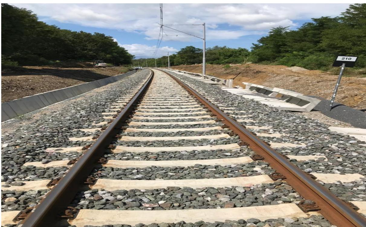
Slika 20. Ugradnja gotovih betonskih odvodnih kanalica tipa 1, Pružne građevine
