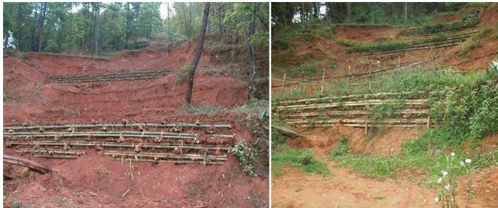
Slika 23: Potporna konstrukcija od bambusa [13]
