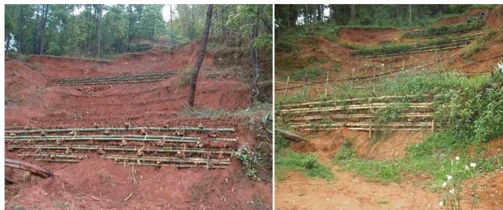
Slika 23: Potporna konstrukcija od bambusa [13]
