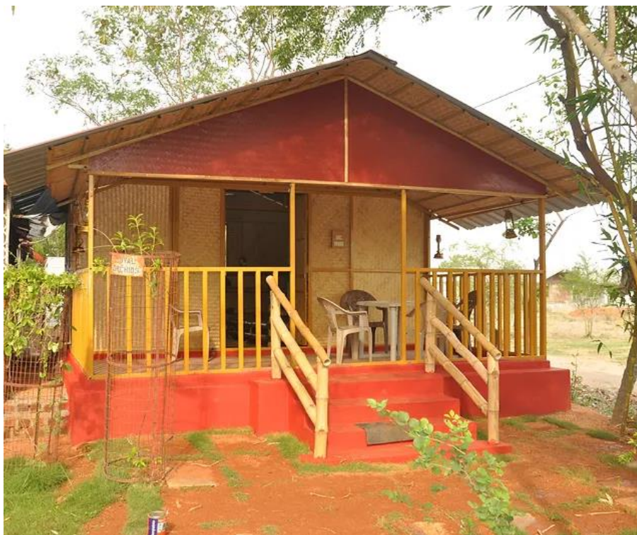
Slika 6: Obiteljska kuća u Indiji (Bamboo House India)
