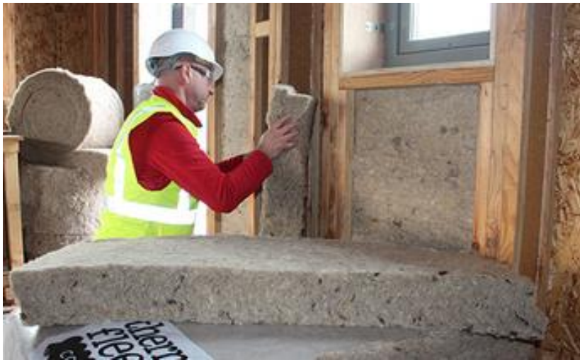
Slika 2. Postavljanje ovčje vune
