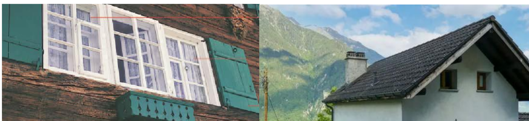
Slika 1. Dvostruki prozori i krov u tipičnoj planinskoj kući
