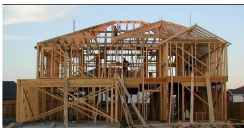
Slika 23. Suha gradnja – platformframe konstrukcija
