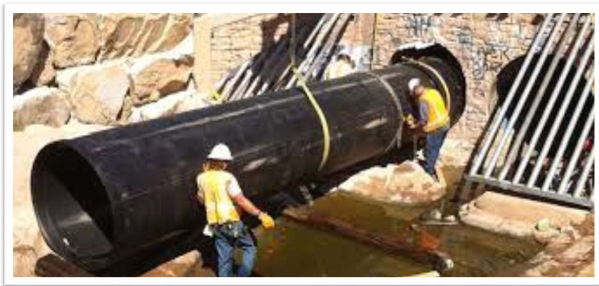
Slika 15 : Metoda klizajuće obloge [14]
