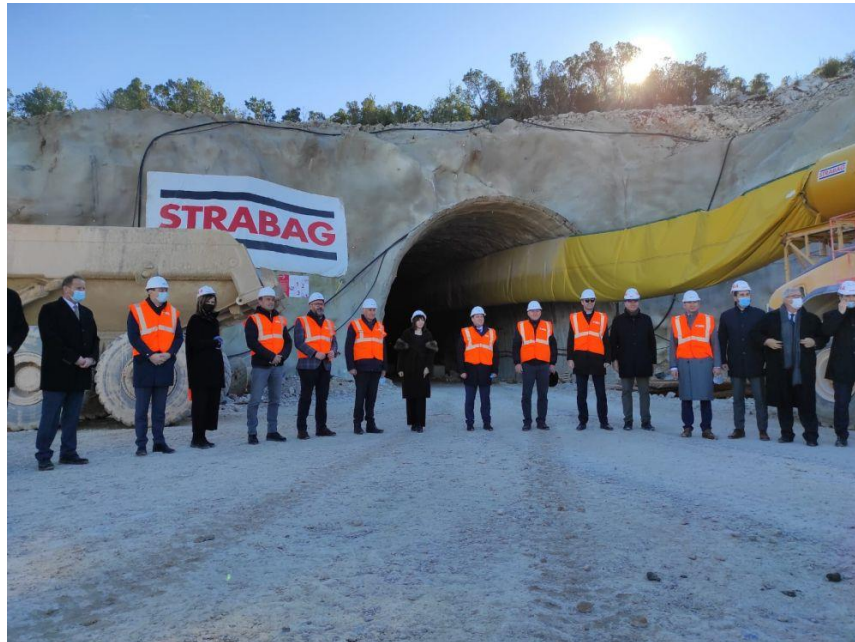
Slika 37. Završetak probijanja tunela [22]
