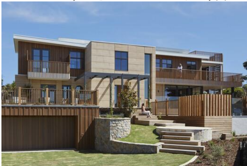
Slika 17: Obiteljska kuća „Moonah Tree House“ u Moonah, Australija [42]
