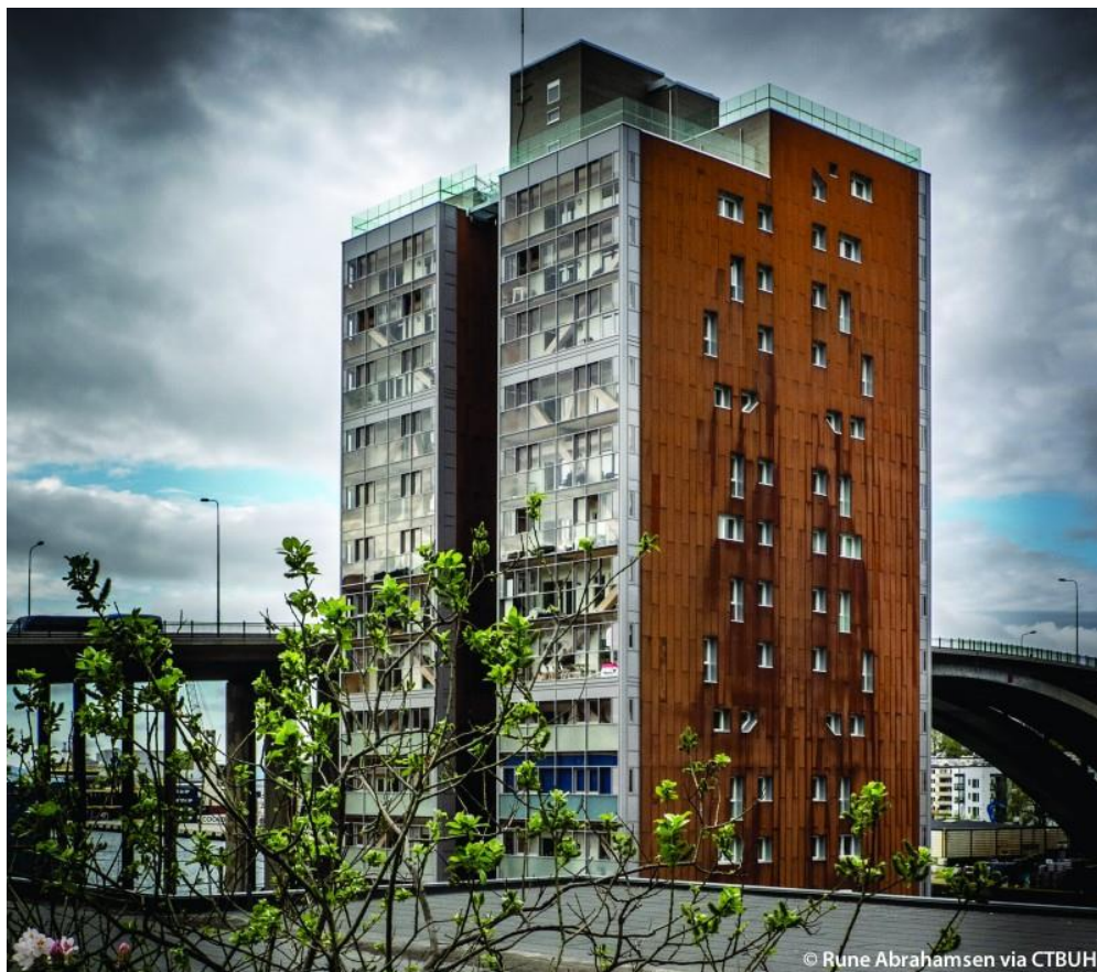
Slika 2: Stambena zgrada „Treet“ u Bergen, Norveška [10]
