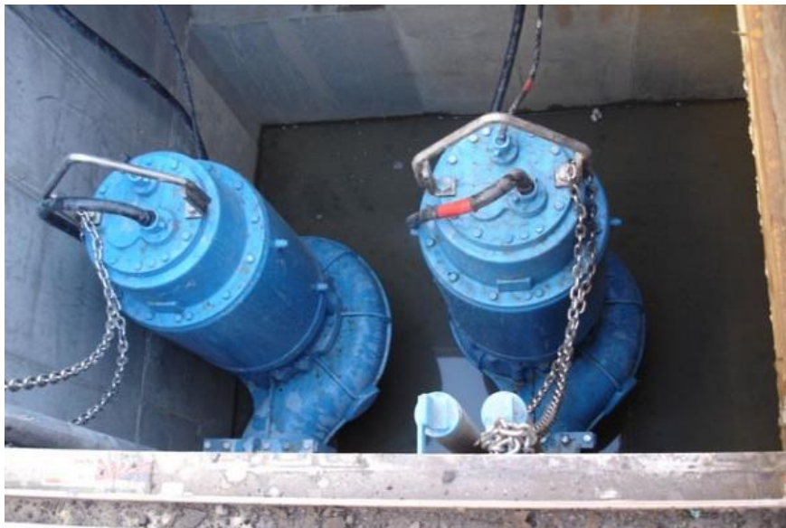
Slika 14 Crpna stanica ukopanog tipa s mokrom izvedbom [3]
