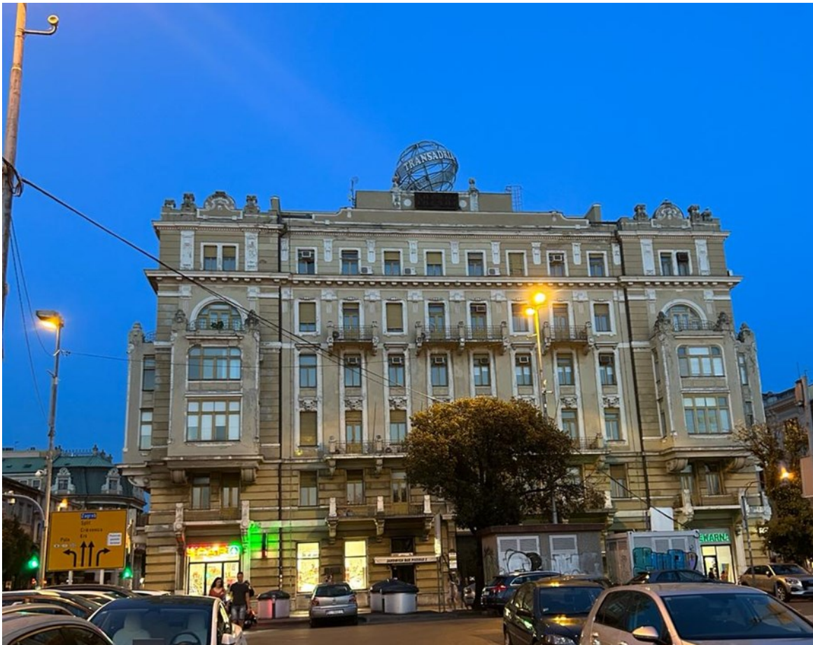
Slika 7 Pogled na zapadno pročelje (izradio autor)
