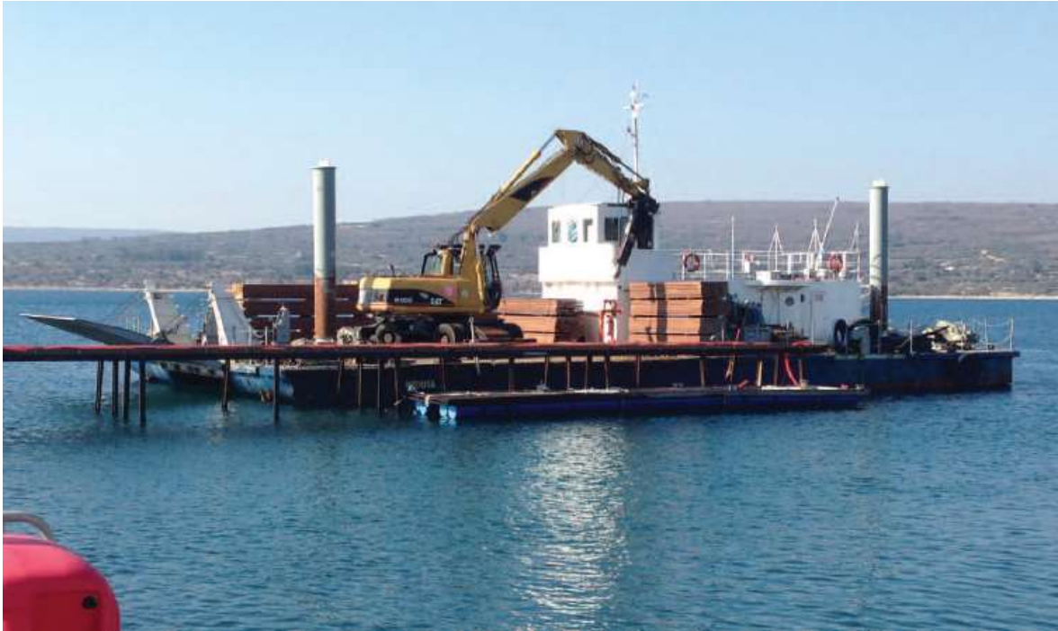
Slika 34: Radnog pontona „Medusa“ i Caterpillar bagera M322C [3]
