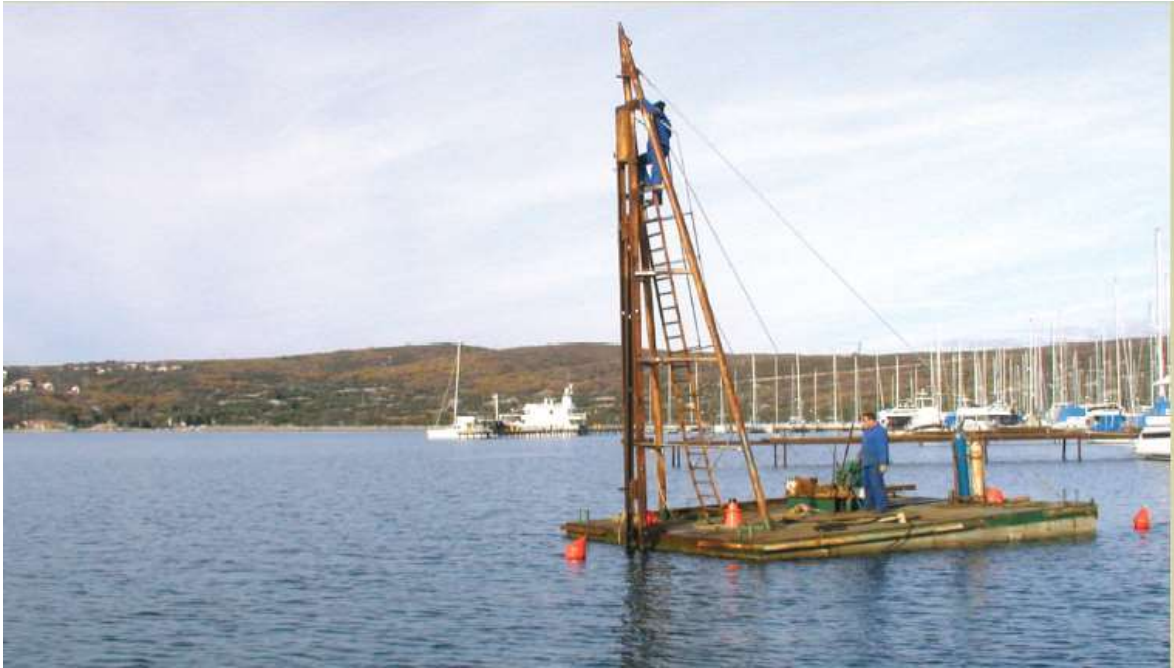
Slika 33: Ponton s “makarom“ za zabijanje pilona [3]
