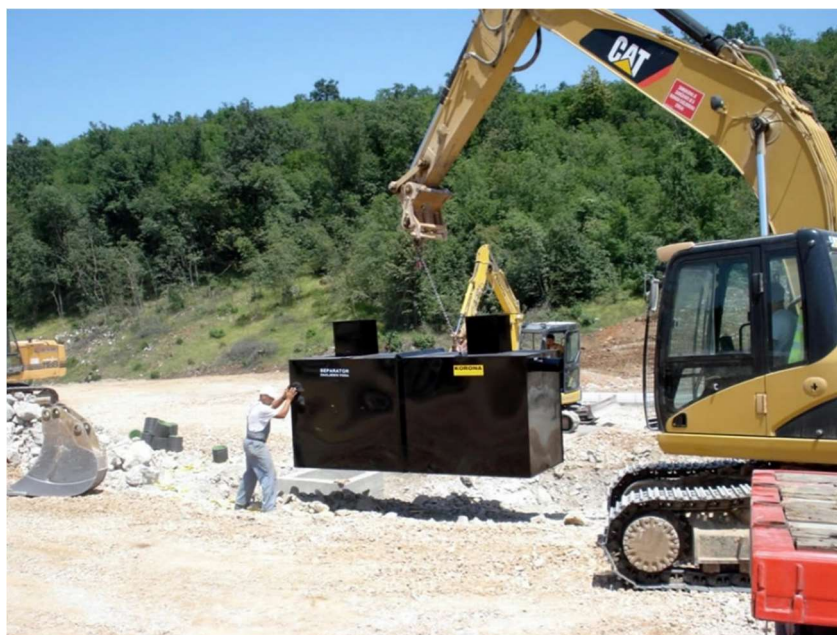
Slika 82: Prikazuje ugradnju separatora [20]
