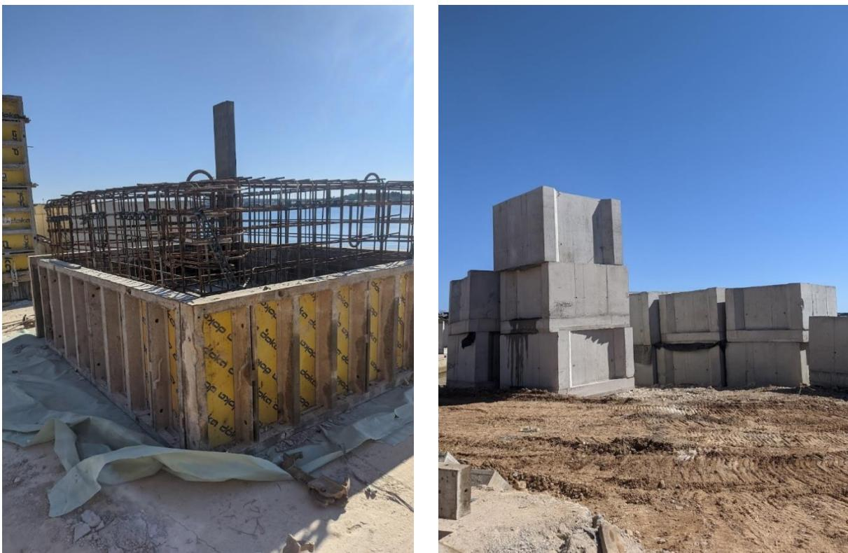
Slika 11. a) Betoniranje AB elemenata, b) Gotovi AB elementi za izvedbu obalnih zidova (izvor: vlastita fotografija)
