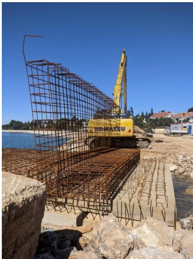
Slika 12. Armatura parapetnog zida (izvor: vlastita fotografija)
