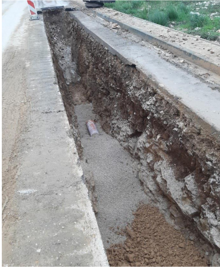
Slika 24. Izrada obloge oko cjevovoda Vrsi (Marko Dujić)
