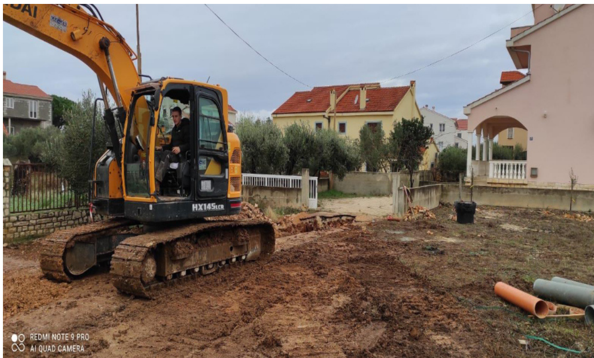
Slika 22. Strojni iskop rova za cjevovod i okna (Marko Dujić)
