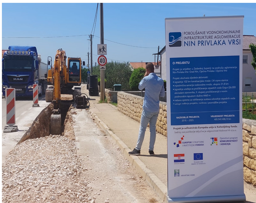
Slika 26. Prikaz stanja na gradilištu projekta poboljšanja vodnokomunalne infrastrukture aglomeracije Nin-Privlaka-Vrši (Marko Dujić)
