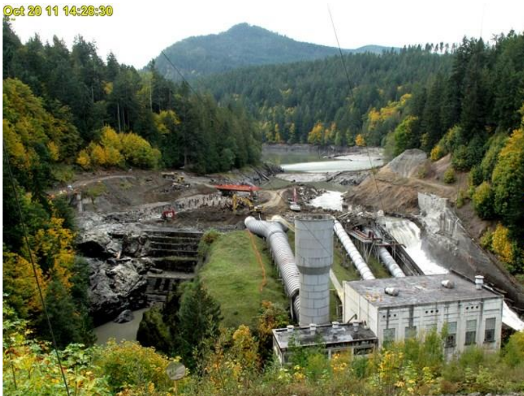
Slika 28: Uklanjanje brane Elwha [36]
