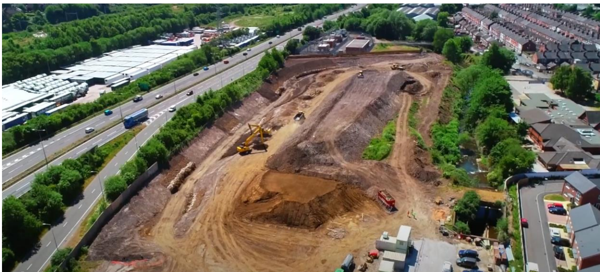
Slika 10: Izvođenje preusmjerenja rijeke Trent na mjestu starog nogometnog terena Stoke Cityja [17]
