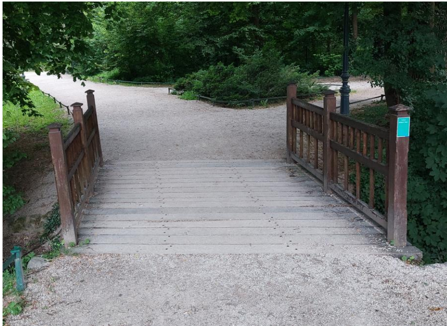
Slika 130: Primjer drvenog mostića za prelaz kanala [fotografija: autor, 01.07.2023.]
