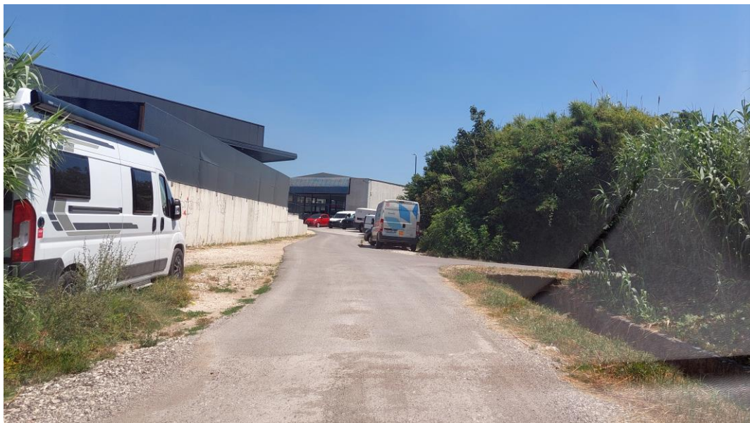
Slika 82: Mjesto uklopa na postojeću prometnicu [fotografija: autor, 15.07.2023.]
