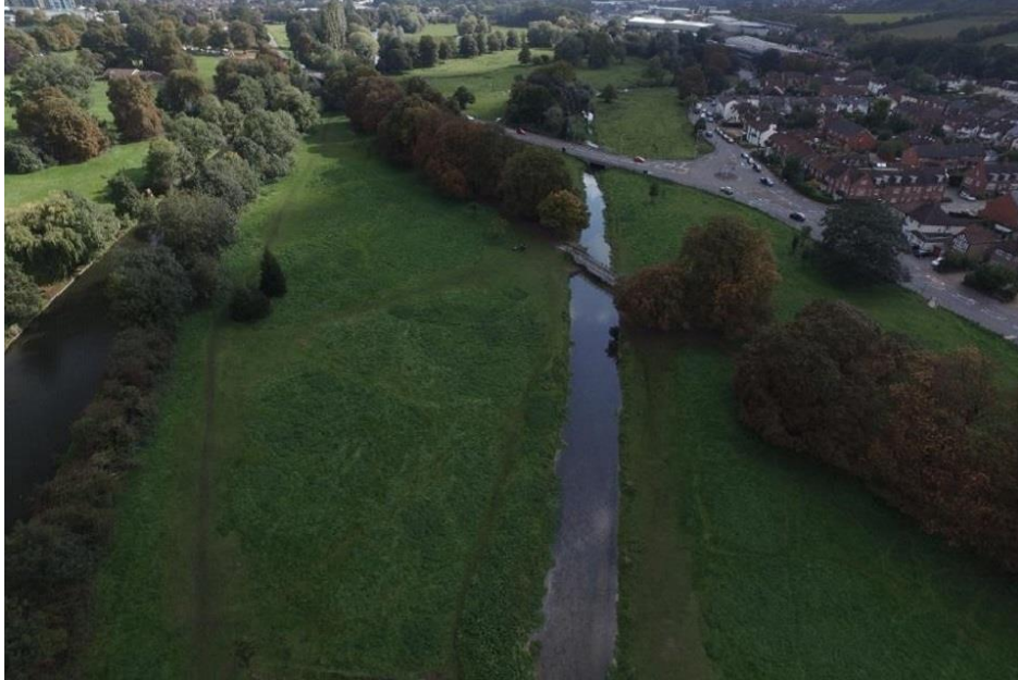
Slika 2: Ravni tok rijeke Bulbourne prije zahvata [6]
