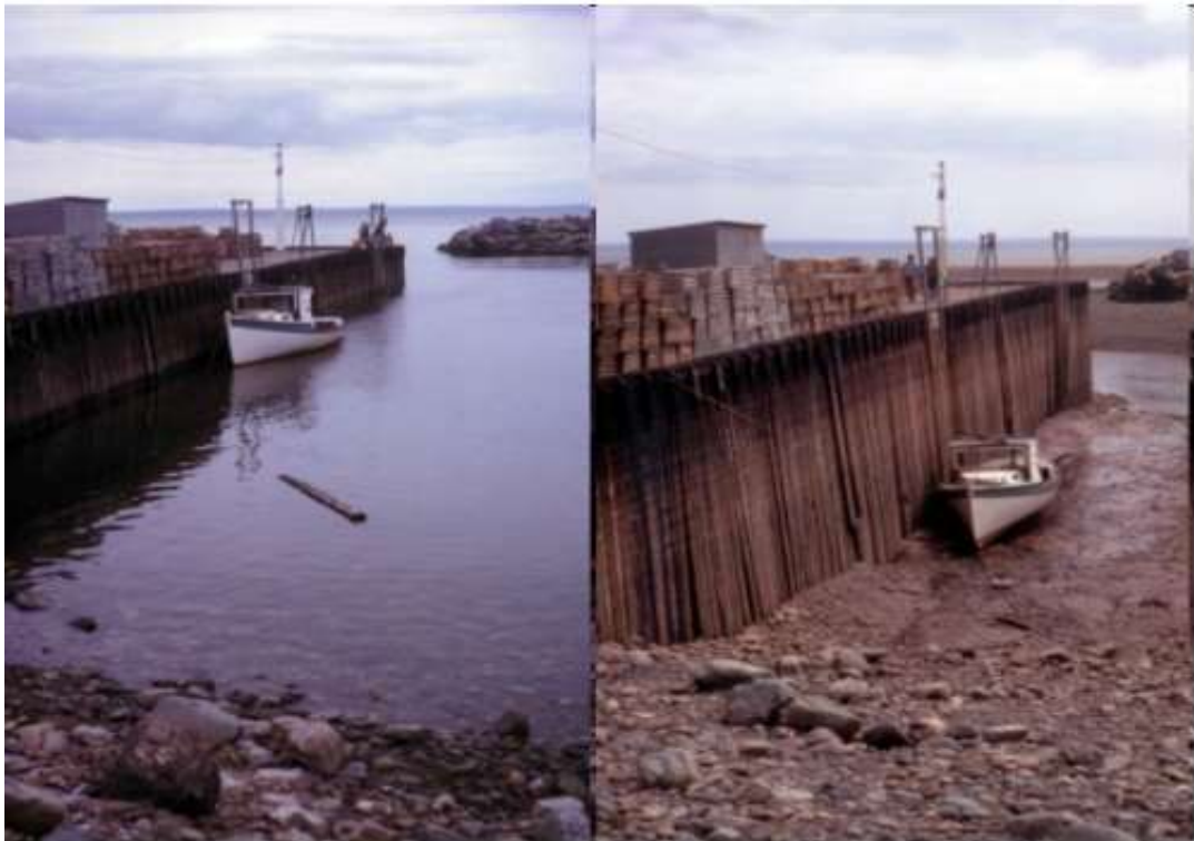
Slika 9. Utjecaj plimnih valova na građevine [1]
