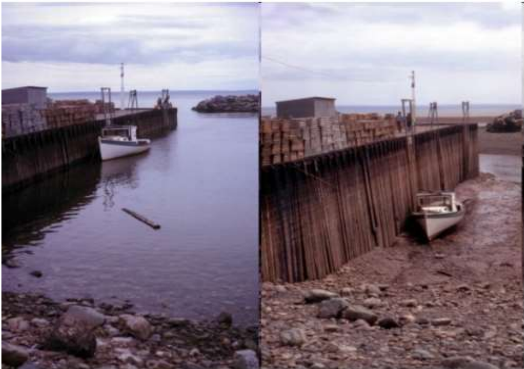
Slika 9. Utjecaj plimnih valova na građevine [1]
