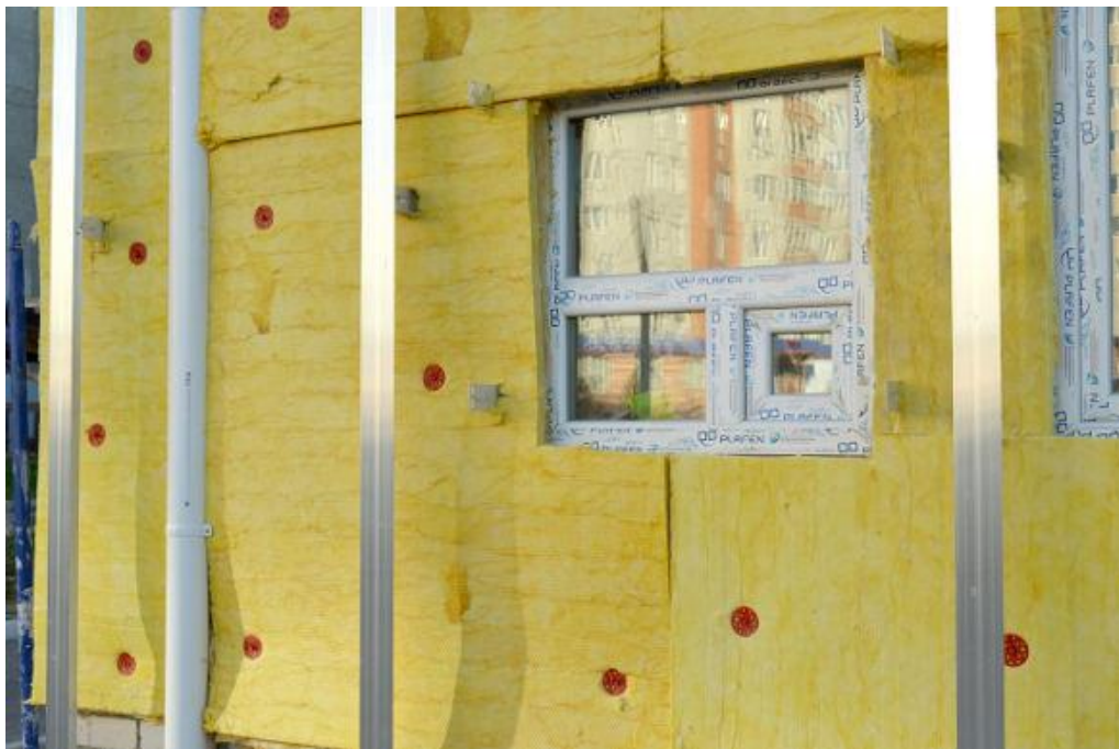
Slika 2: Toplinska izolacija građevine [6]
