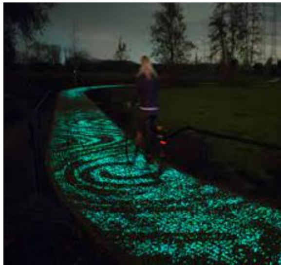
Slika 26 Biciklistička staza napravljena od fotoluminiscentnog betona[11]
