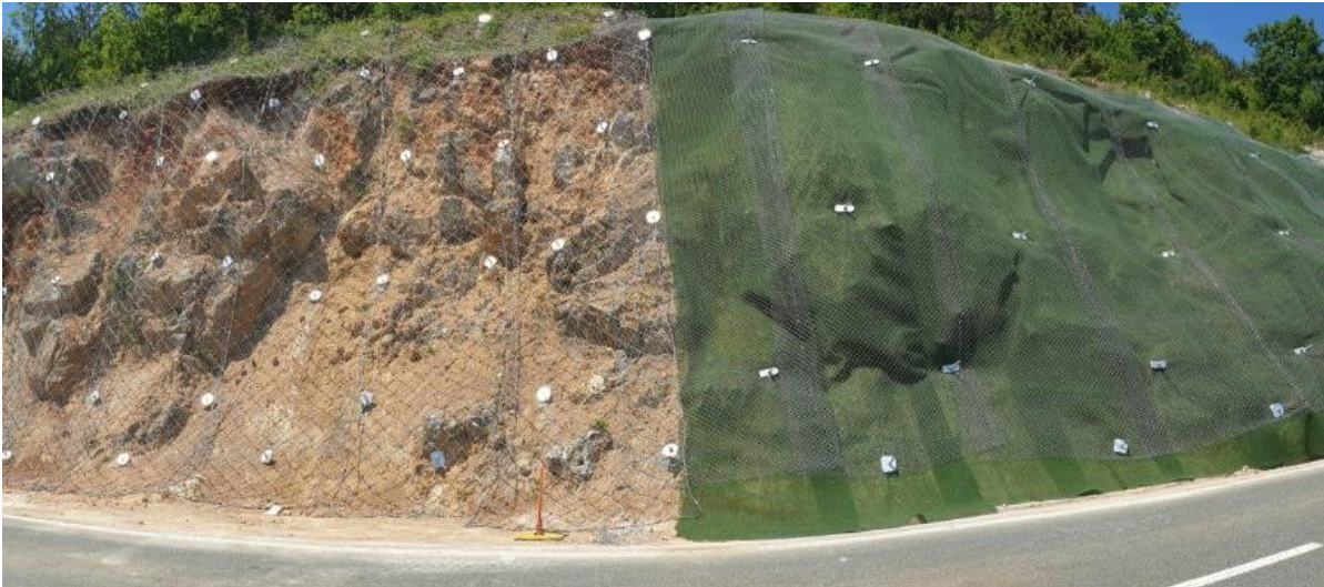
Slika 12. Zaštita pokosa mrežom sa (desno) i bez mreže za zaštitu od erozije (lijevo)
