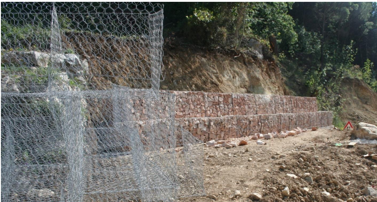
Slika 22. Gabionski koševi dimenzija 1,0m x 1,0m x 2,0m i dio dovršenog gabionskog zida
