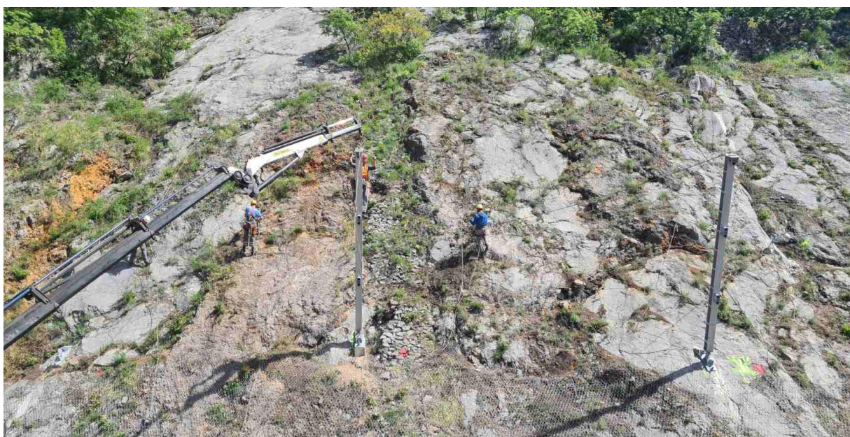
Slika 20. Postavljanje stupova barijere za zaštitu od odrona
