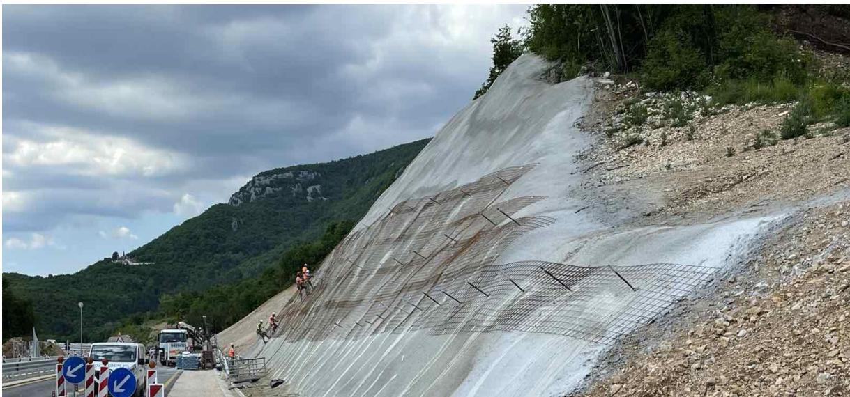
Slika 4. Geotehnička sidra u mlaznom betonu
