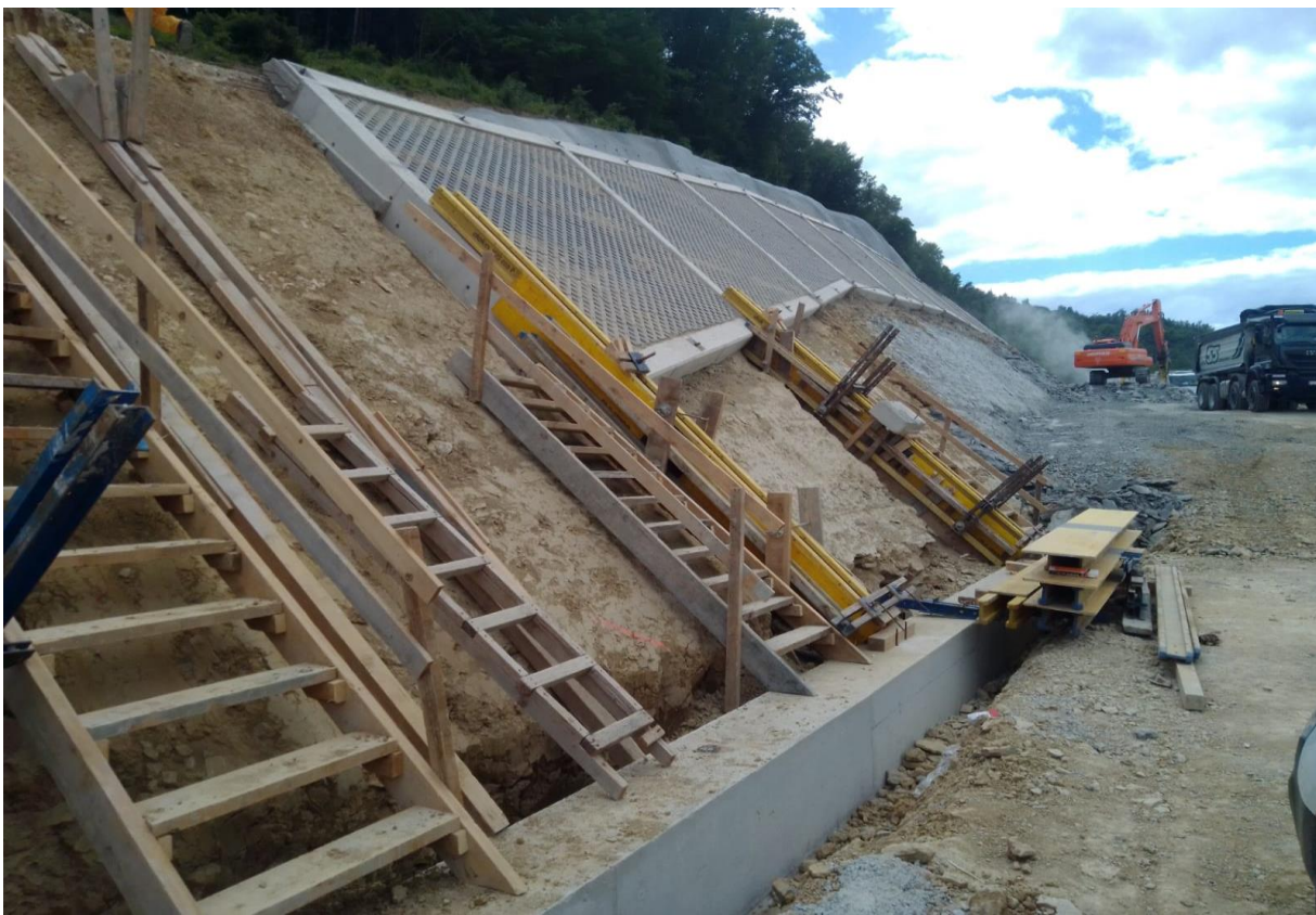
Slika 29. Eko prstenovi i roštiljna konstrukcija u fazi izvođenja
