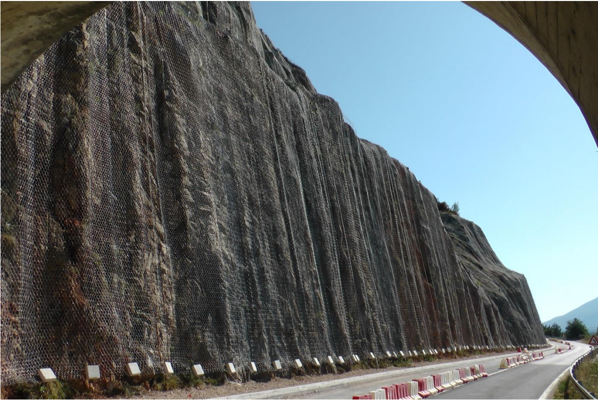
Slika 17. Zaštita stijenskog pokosa dvostruko uvijenom heksagonalnom mrežom (izvor: Octopus Rijeka)
