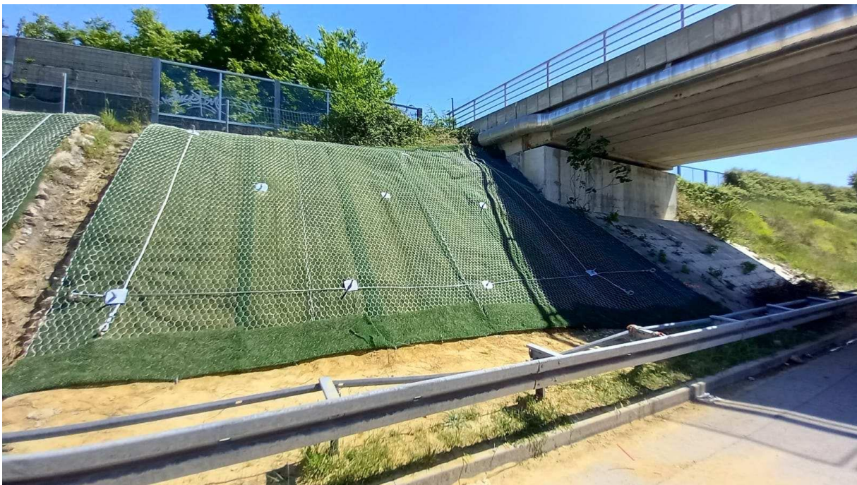
Slika 13. Nosiva mreža s mrežom za zaštitu od erozije
