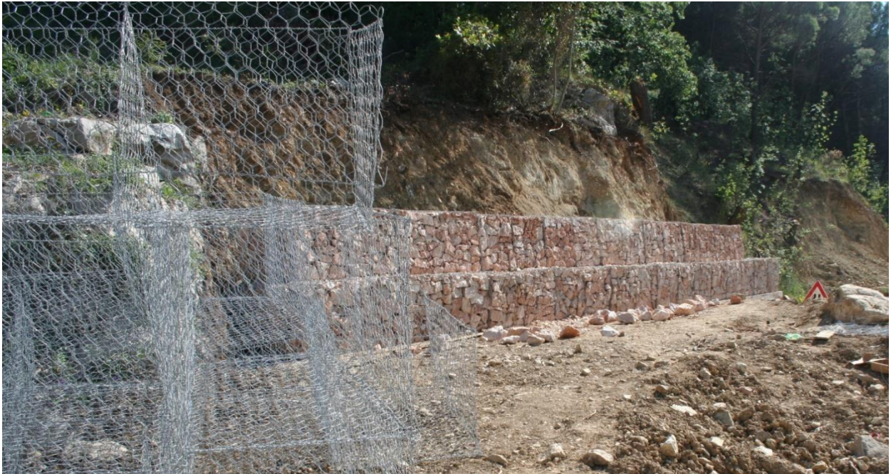
Slika 22. Gabionski koševi dimenzija 1,0m x 1,0m x 2,0m i dio dovršenog gabionskog zida
