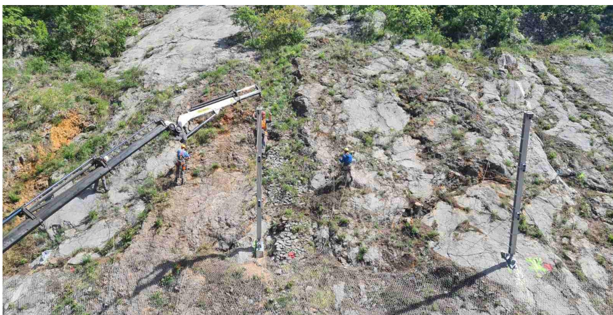
Slika 20. Postavljanje stupova barijere za zaštitu od odrona
