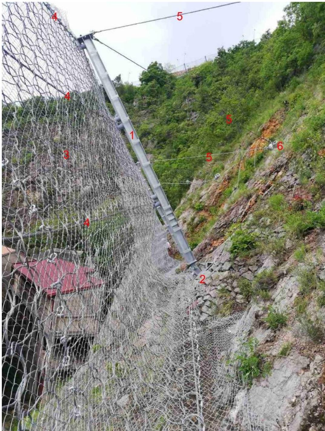
Slika 21. Elementi barijere za zaštitu od odrona; 1-čelični stup, 2-temelj s podložnom pločom, 3-mreža, 4-nosiva užad, 5-zatezna užad, 6- usidreni kočioni prstenovi
