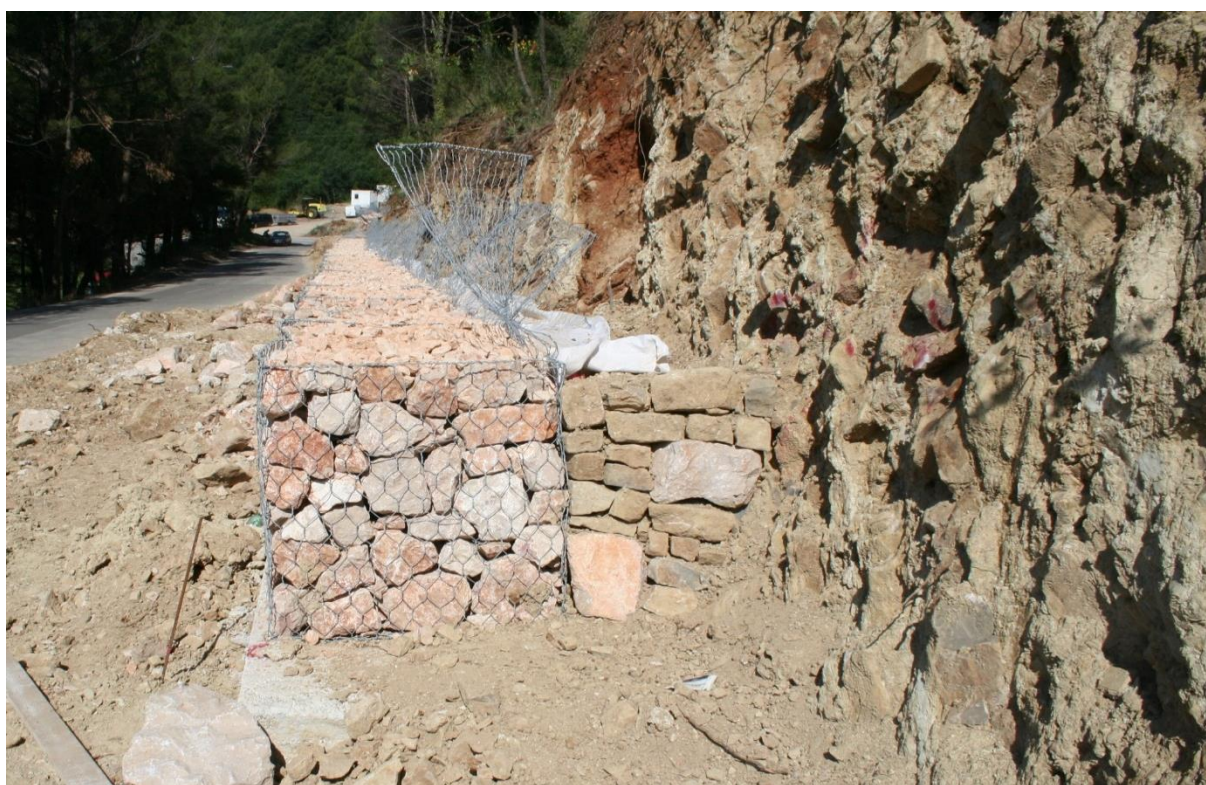
Slika 23. Punjenje gabionskih koševa kamenim materijalom
