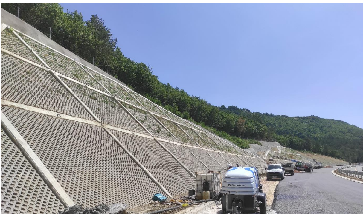
Slika 30. Zaštita pokosa roštiljnom konstrukcijom s Eko prstenovima
