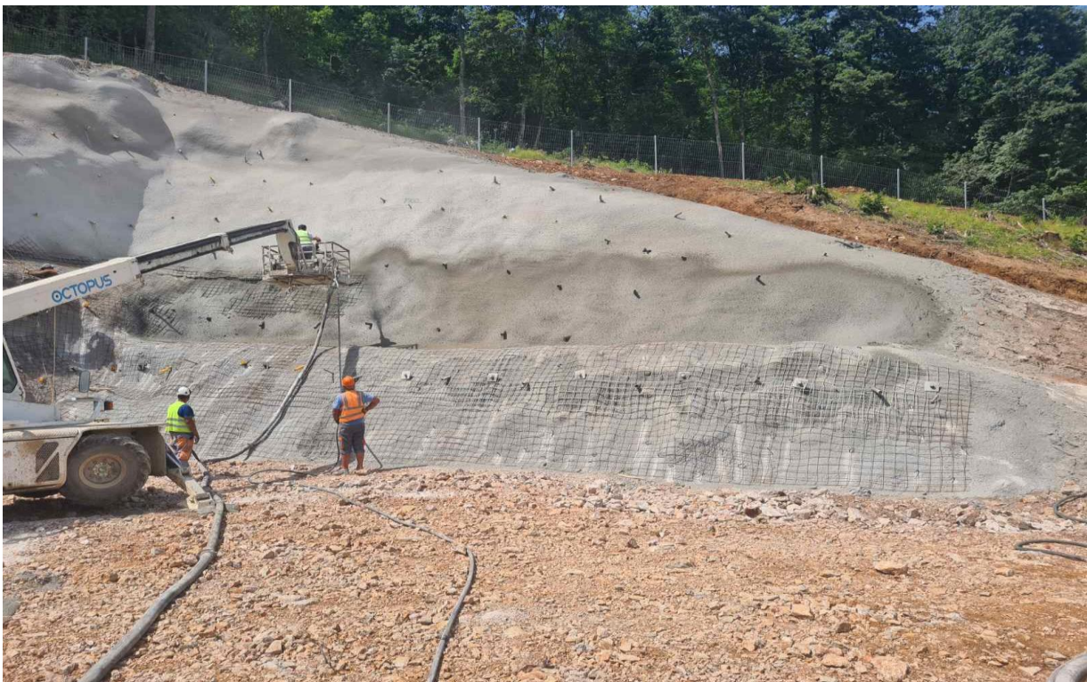
Slika 11. Nanošenje drugog sloja mlaznog betona preko armaturne mreže
