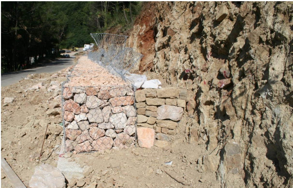
Slika 23. Punjenje gabionskih koševa kamenim materijalom
