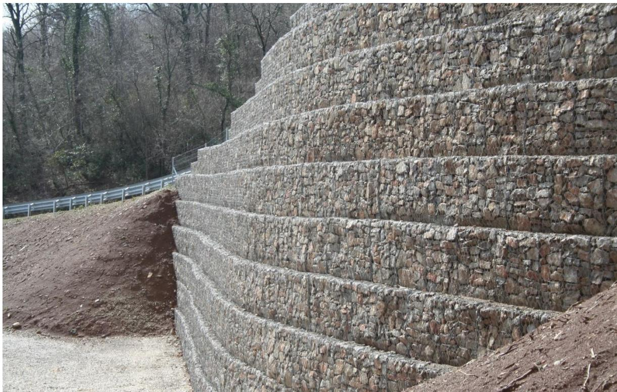
Slika 24. Zaštita pokosa Terramesh sustavom
