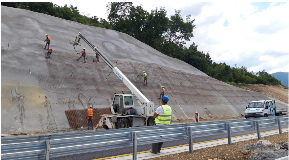
Slika 33. prikazuje izvođenje radova pomoću Manipulatora Merlo roto i alpinista
