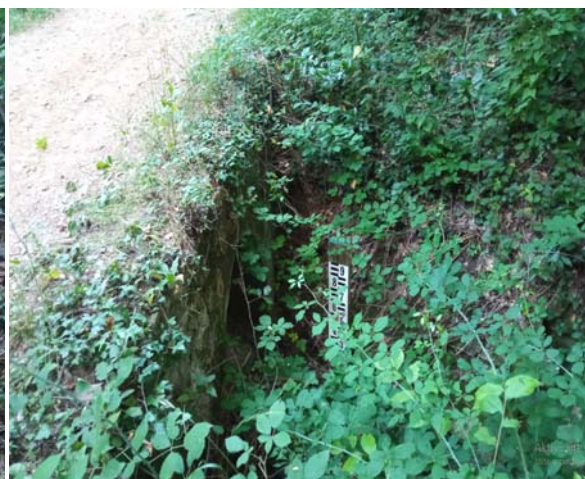
Slika 77. Cestovni propust (pc1)
