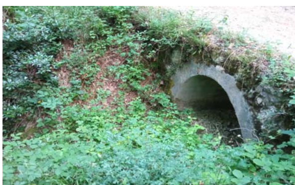
Slika 78. Cestovni propust (pc1)
