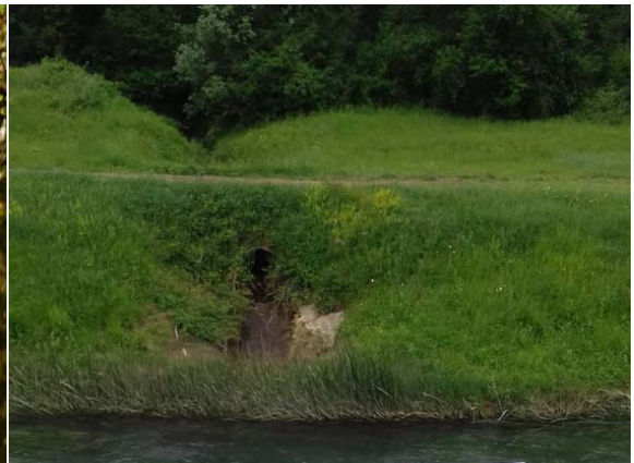
Slika 111. Cestovni propust (pc1)
