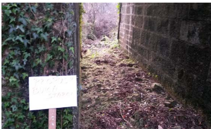
Slika 174. Gornji tok – cestovni propust (pc1)
