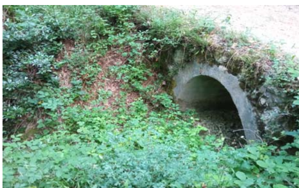
Slika 78. Cestovni propust (pc1)
