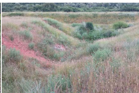
Slika 70. Zemljani kanal-spoj sa rjekom Rašom
