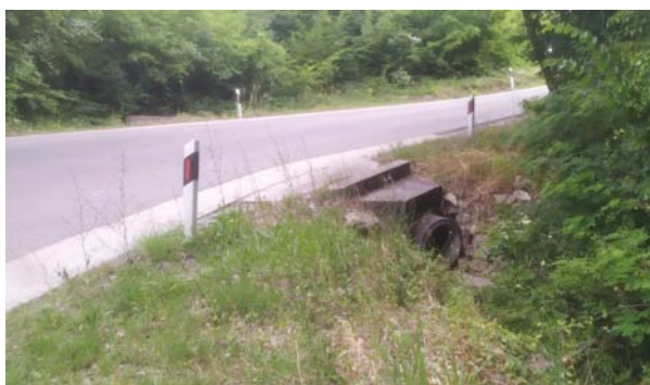
Slika 126. Cestovni propust (pc1)
