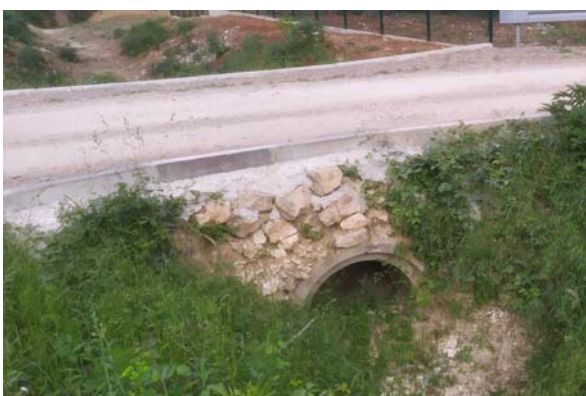
Slika 47. Cestovni propust (pc1)
