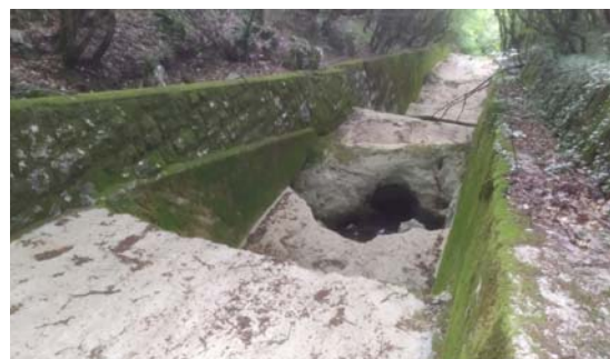
Slika 158. Gornji tok-oštećenje
