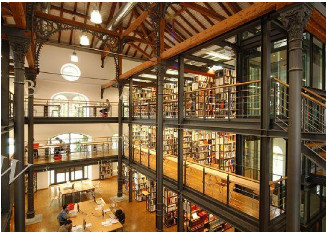
Slika 16: Unutrašnjost knjižnice i njezini glavni konstruktivni elementi
