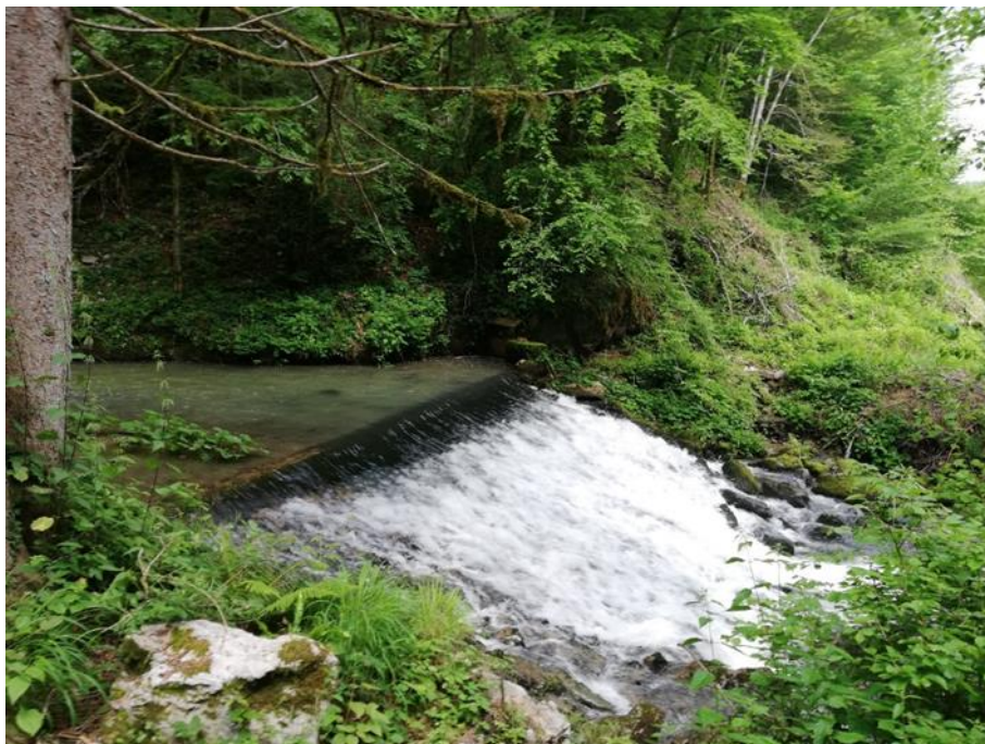
Slika 6 Postojeće stanje vodotoka
