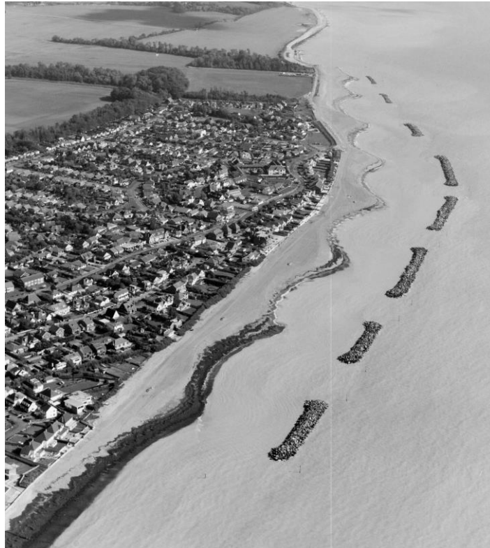
Slika 15 Odvojeni lukobrani uz plažu (The Rock Manual, 2007)
