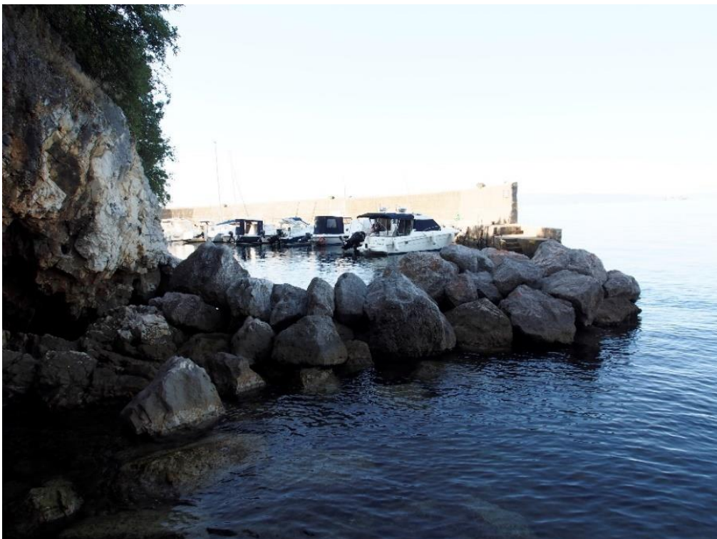
Slika 22 Nasuti lukobran lučice Pećine
