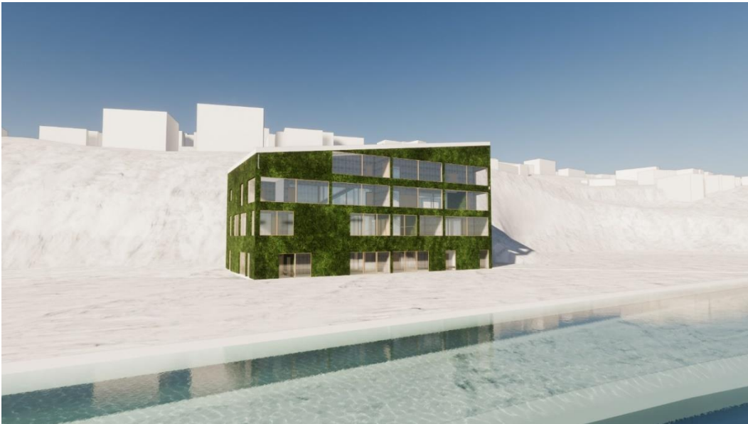
Grafički izvor 17. Prostorski prikaz – Zelena ventilirana fasada bez zasjenjenja
