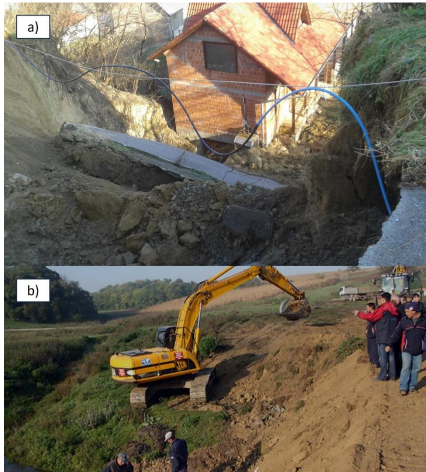
Slika 13 a) odron lesnog tla na području grada Iloka. Preuzeto iz [22], b) sanacija klizišta na području istočne Slavonije. Preuzeto iz [23]
