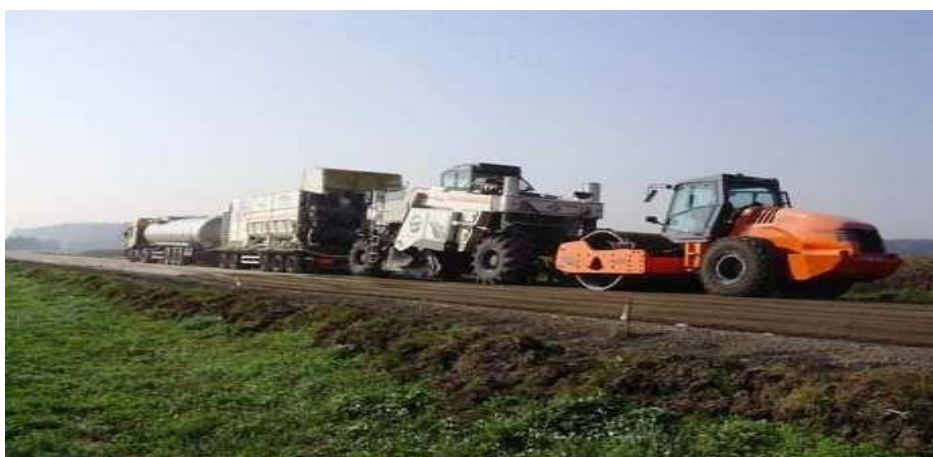
Slika 21: Tehnologija ugradnje na gradilištu [8]
