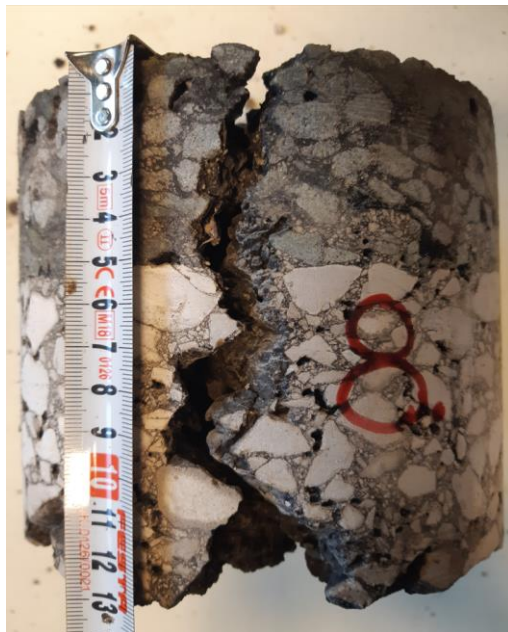
Slika 3: Uzorak jezgre asfaltnog zastora kod poprečne pukotine
