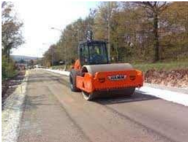
Slika 15. Valjak za mehaničko zbijanje
