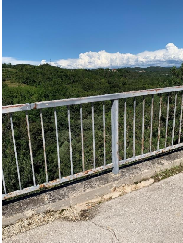
Slika 66: Ograda i rukohvat mosta Vršić
