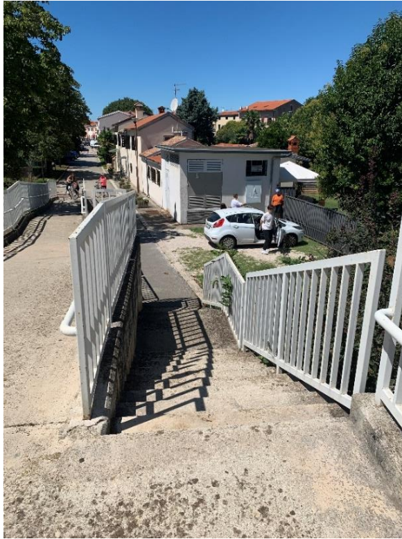
Slika 73: Stubište mosta u Prvomajskoj ulici
