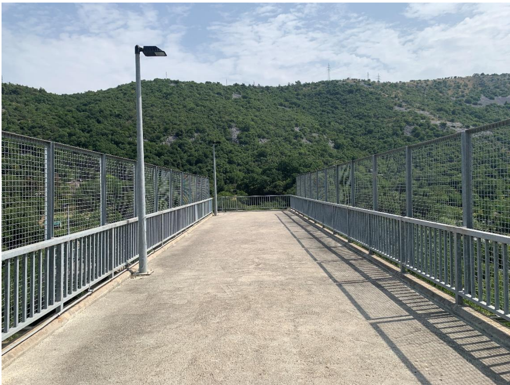
Slika 56: Hodna ploha i ograda mosta iznad Kvarnerske Autoceste
