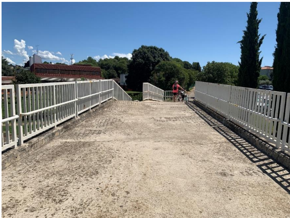
Slika 70: Hodna ploha mosta u Prvomajskoj ulici
