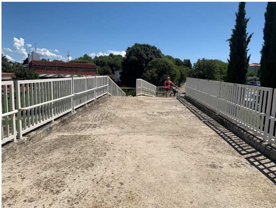
Slika 70: Hodna ploha mosta u Prvomajskoj ulici
