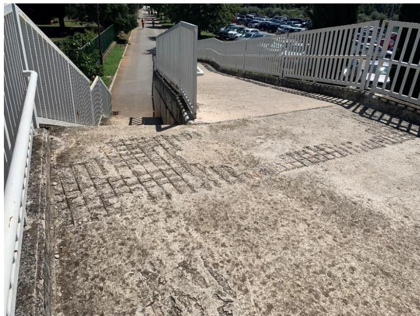
Slika 71: Istrošeni beton na mostu u Prvomajskoj ulici
