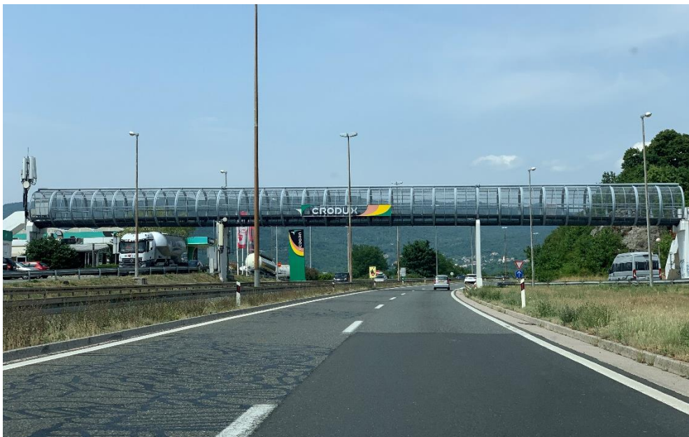
Slika 45: Konstrukcija mosta Vrata Jadrana
