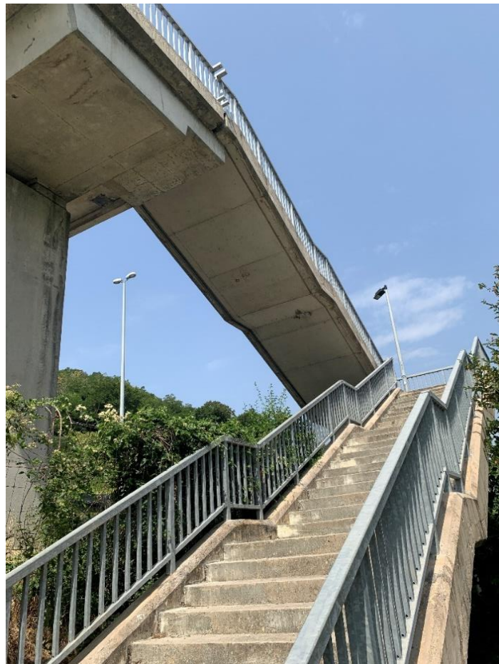
Slika 58: Stubište mosta iznad Kvarnerske Autoceste
