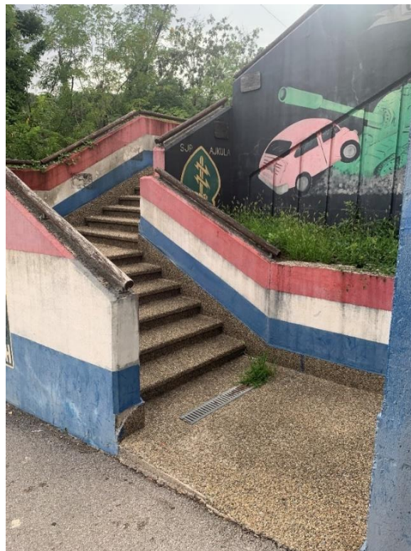
Slika 52: Stubište sa strane ceste
