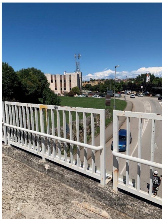
Slika 72: Ograda i rukohvat mosta u Prvomajskoj ulici
