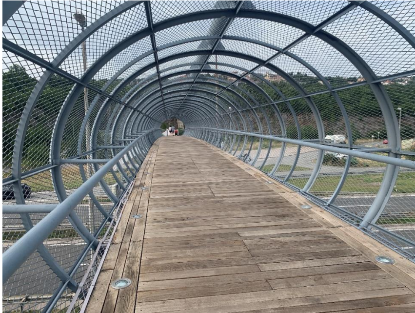
Slika 46: Hoda ploha i ograda mosta Vrata Jadrana
