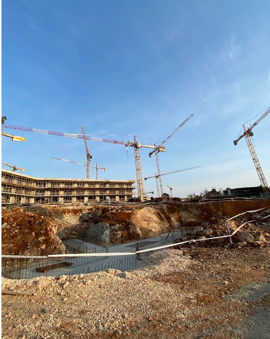
Slika 25: Gradilište Hotela Pinea (Izradio autor)
