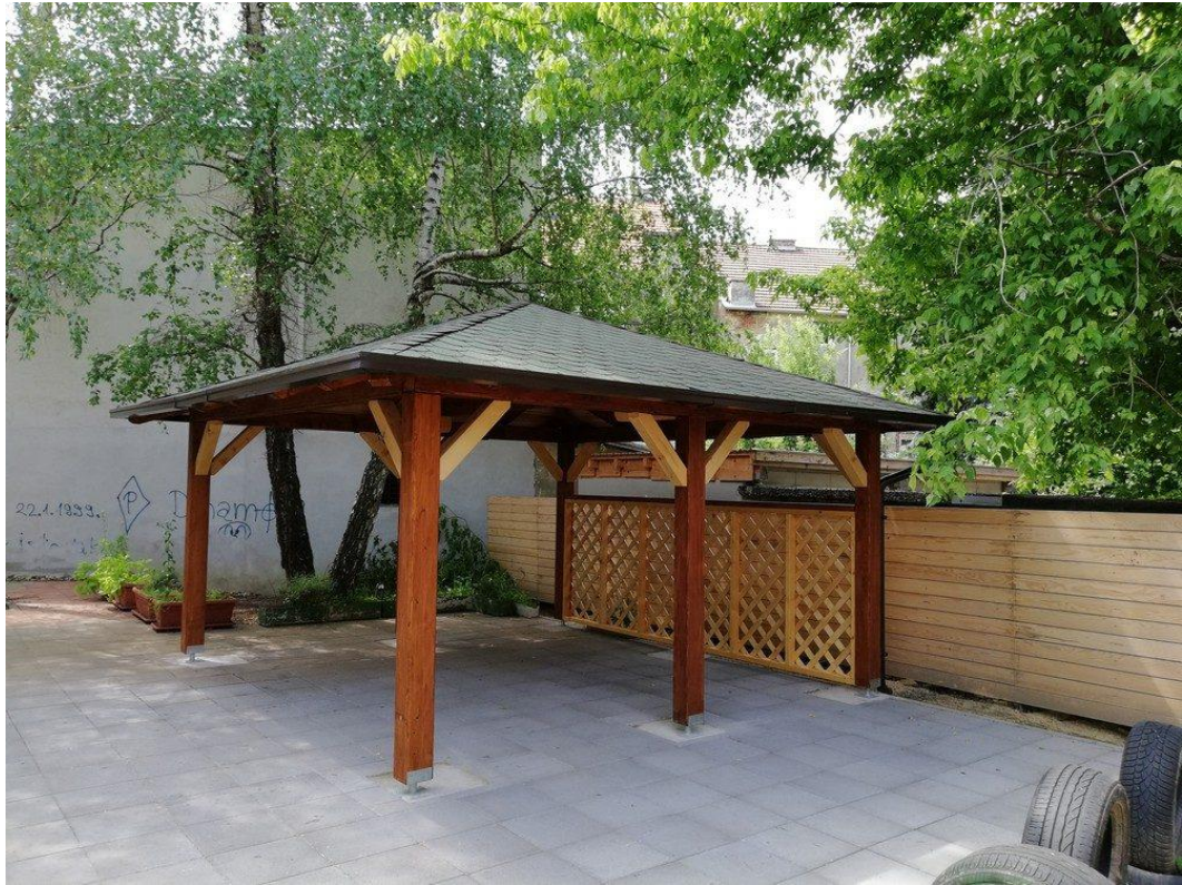
Slika 8. Primjer šatoraste nadstrešnice [17]
