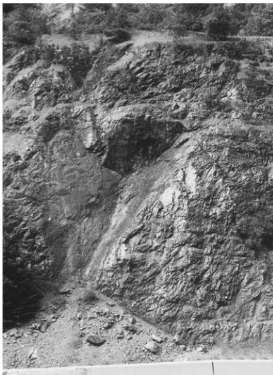
Slika 12. Tipični klinasti slom [2]
