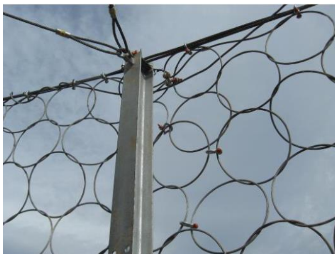
Slika 47. Mreža čeličnih prstenova [35]
