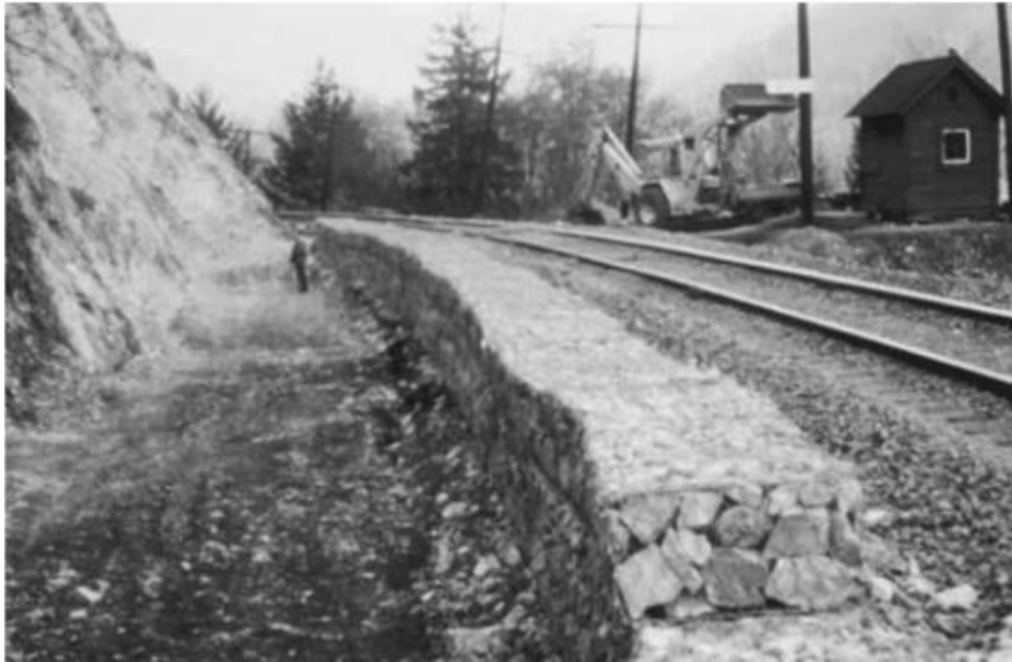
Slika 39. Gabion sa prihvatnim jarkom [2]
