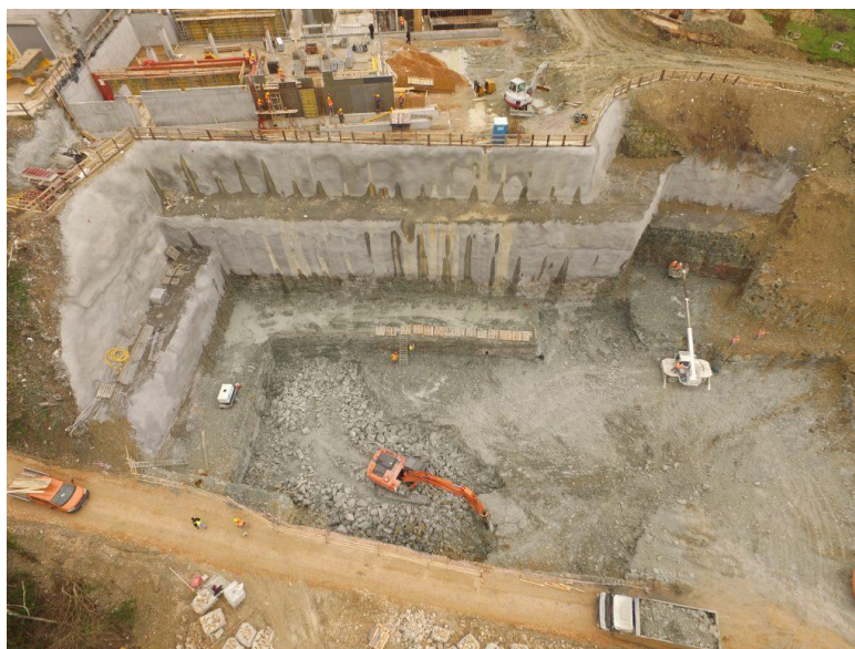
Slika 2: Duboka građevna jama [6]
