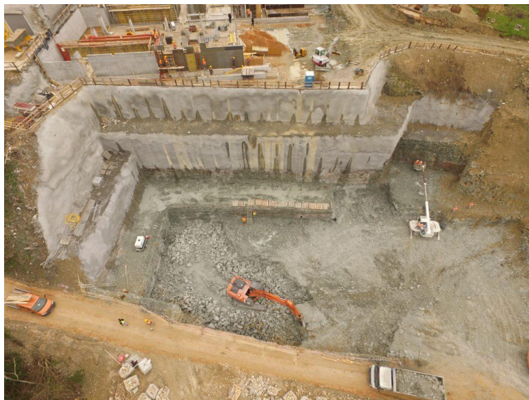
Slika 2: Duboka građevna jama [6]
