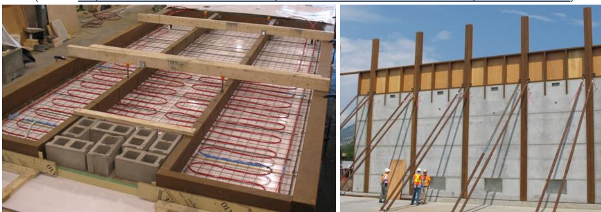
d) Zidni TCC paneli s ugrađenim sustavom grijanja – proizvodnja i ugradnja (izvor: https://structurecraft.com/projects/okanagan-college-gym-wall-panels )
