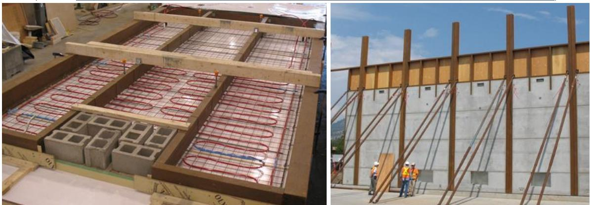
d) Zidni TCC paneli s ugrađenim sustavom grijanja – proizvodnja i ugradnja
