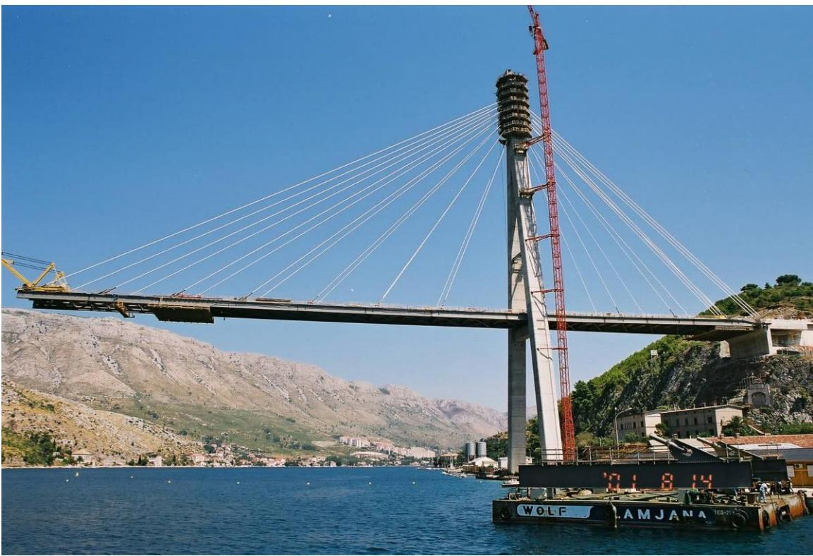
*Slika 3: Ovješeni spregnuti sklop u fazi gradnje*
