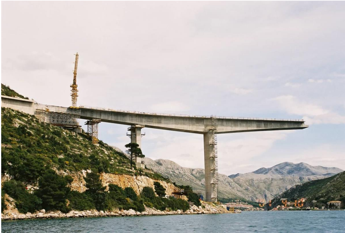
Slika 2: Prednapeti betonski sklop u fazi gradnje
