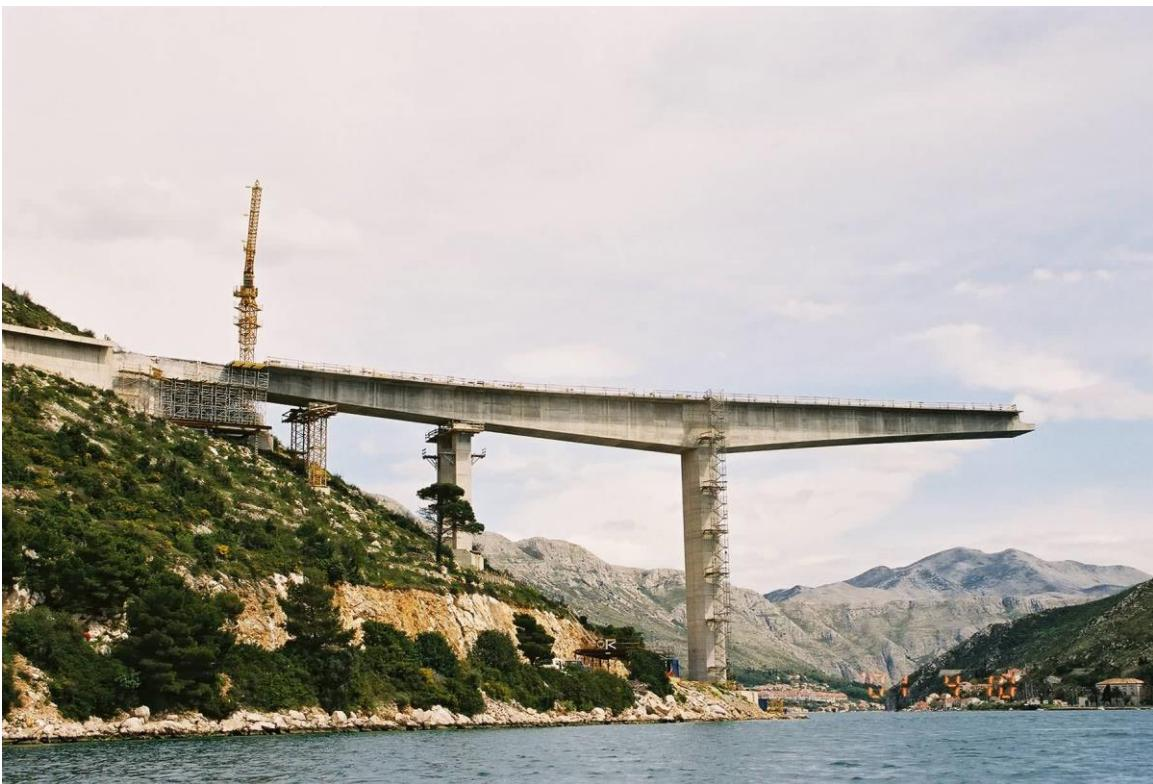
*Slika 2: Prednapeti betonski sklop u fazi gradnje*
