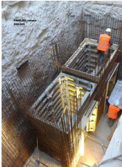
Slika 10. Fotografija betoniranja okna dizala. D. Sošić: Rekonstrukcija hotela President u Dubrovniku 2013. godine, diplomski rad, Sveučilište u Rijeci, Građevinski fakultet, Rijeka, 2020.
