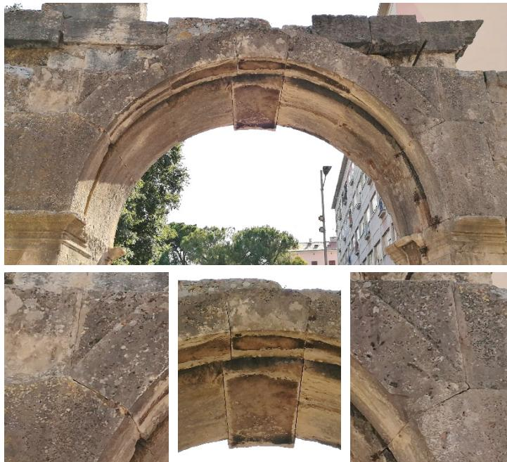
*Slika 2. Otvaranje zglobova na primjeru kamenog luka (Dvojna vrata u Puli)*
