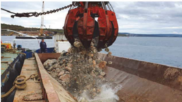
Slika 15. Utovar iskopanog materijala u klapetu [28]
