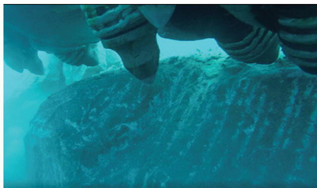
Slika 14. Nedovoljna učinkovitost iskopa pomoću hidrauličke glodalice [28]
