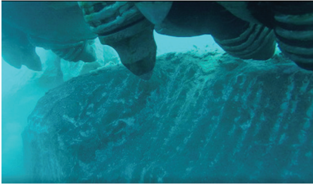
Slika 14. Nedovoljna učinkovitost iskopa pomoću hidrauličke glodalice [28]
