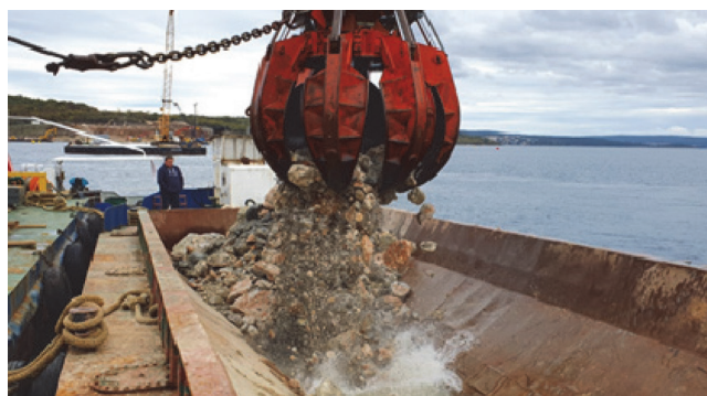
Slika 15. Utovar iskopanog materijala u klapetu [28]
