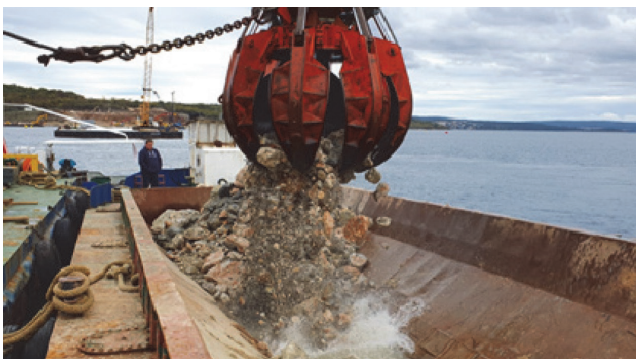
Slika 15. Utovar iskopanog materijala u klapetu [28]
