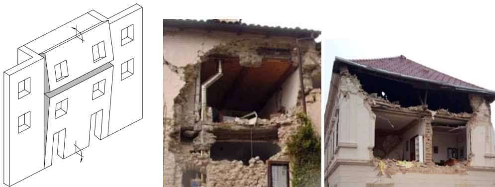
Slika 12. Formiranje vertikalnog luka: shema [2], primjeri [1,7]
