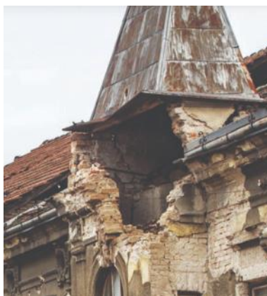
Slika 6. Slom ugla nakon potresa u Petrinji 2020.godine [8,10]
