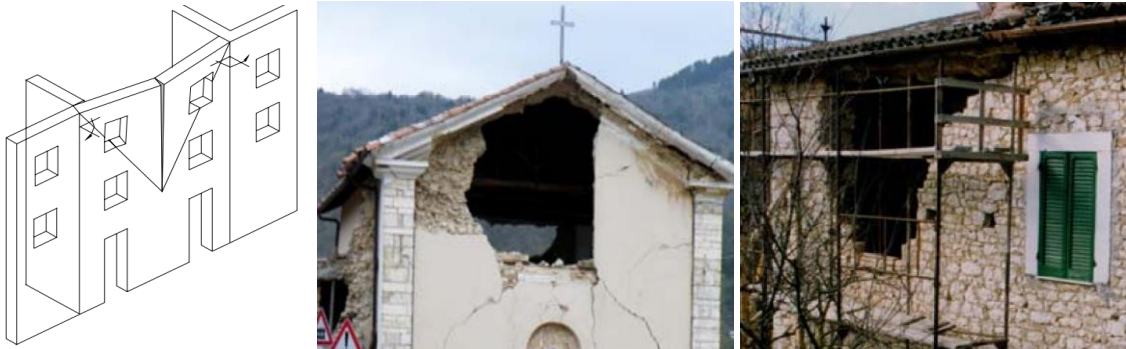
Slika 13. Formiranje horizontalnog luka: shema [2], primjeri [1]
