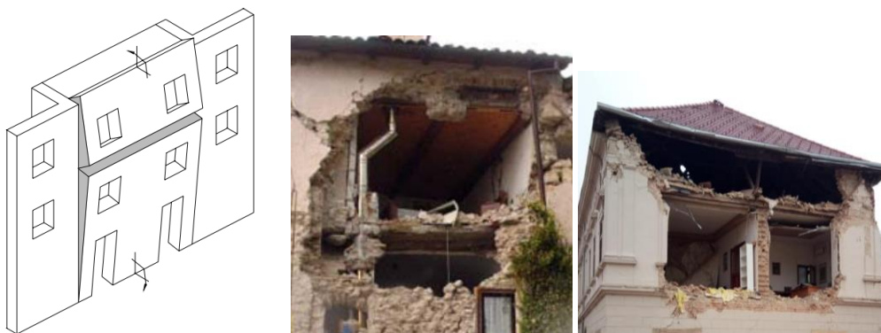
Slika 12. Formiranje vertikalnog luka: shema [2], primjeri [1,7]
