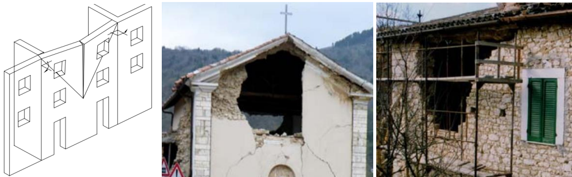
Slika 13. Formiranje horizontalnog luka: shema [2], primjeri [1]
