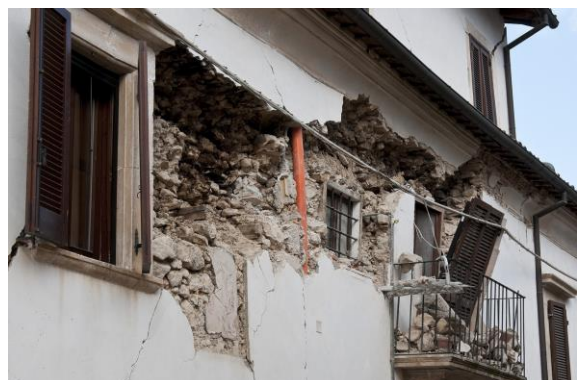
Slika 21. Lokalni slom zida: shema [2], primjer [10]
