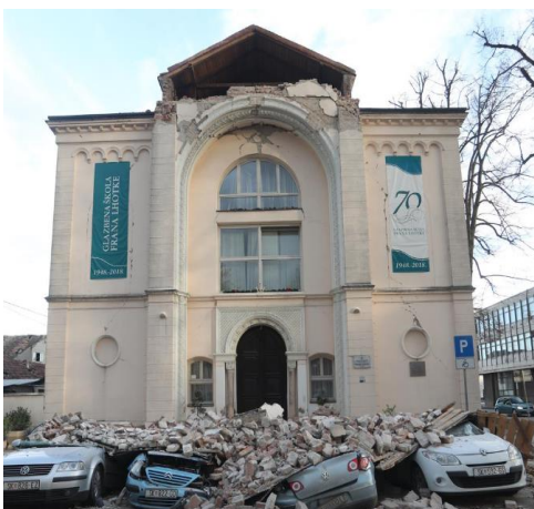
Slika 19. Prevrtanje lastavice zabata nakon potresa u Petrinji 2020.godine [9,12]
