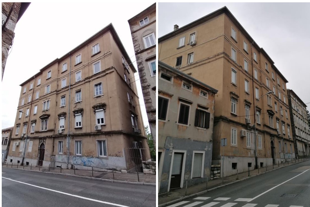
Slika 68. Prikaz pročelja stambene zgrade u Vukovarskoj ulici
