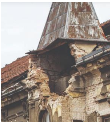
Slika 6. Slom ugla nakon potresa u Petrinji 2020.godine [8,10]
