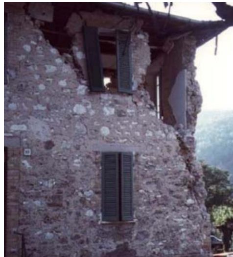
Slika 5. Slom ugla zida: shema [2], primjer [1]
