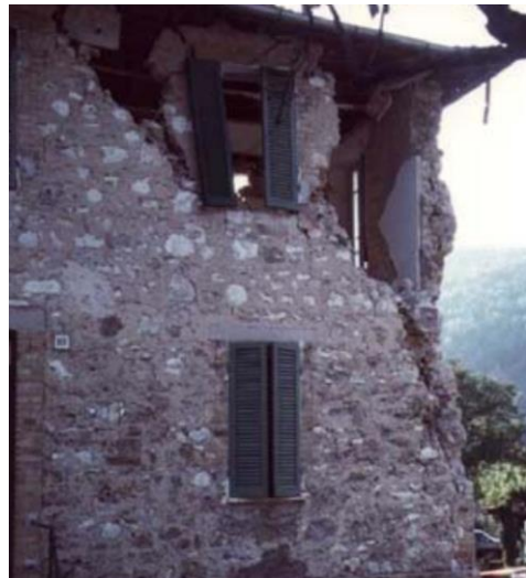
Slika 5. Slom ugla zida: shema [2], primjer [1]
