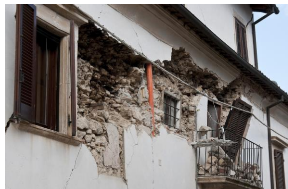
Slika 21. Lokalni slom zida: shema [2], primjer [10]
