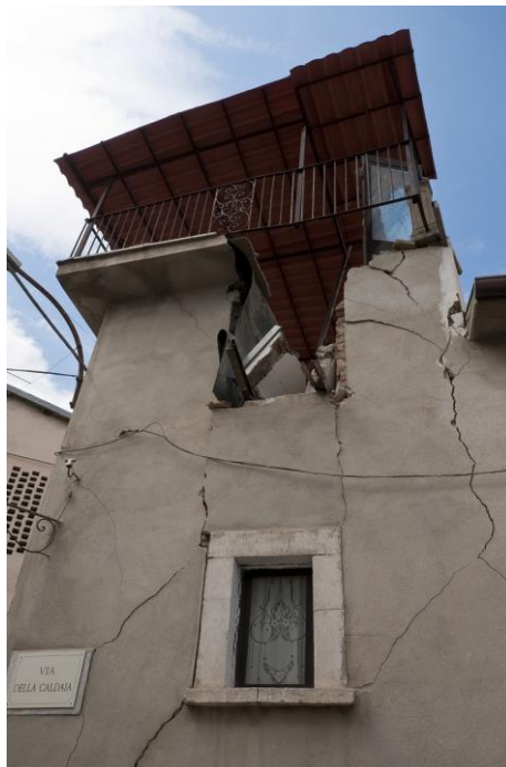
Slika 11. Prevrtanje vertikalne trake [10]
