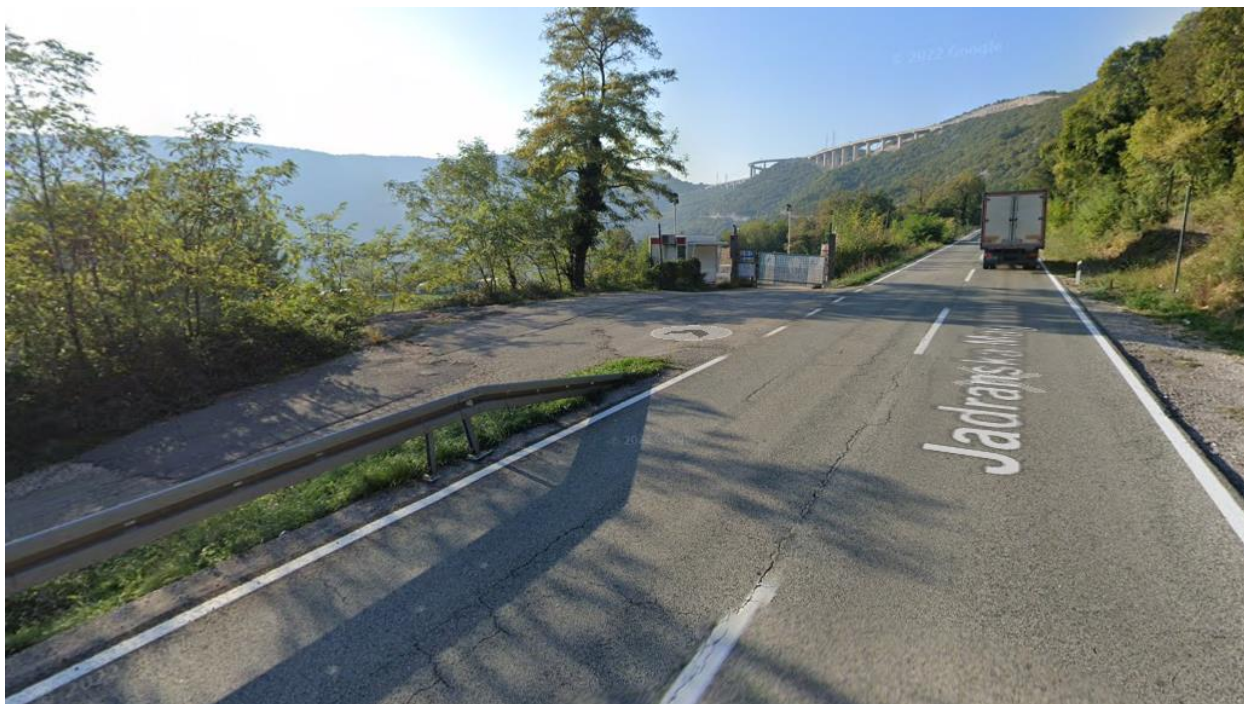
Slika 1. Postojeći prilaz nogometnom terenu i pomoćnim prostorijama kluba [6].
