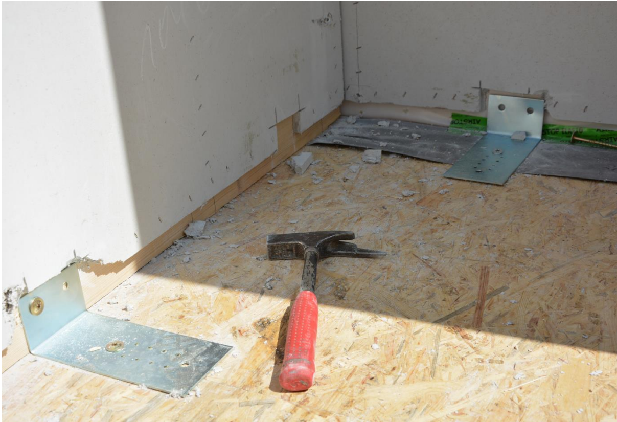
Slika 12 Pričvršćivanje panela – Slaganje u sustavu frame
