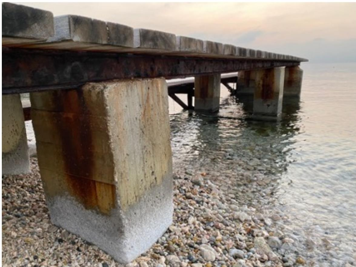
Slika 4: Betonski stupovi zahvaćeni korozijom – Kostrena, (izvor: vlastita fotografija)
