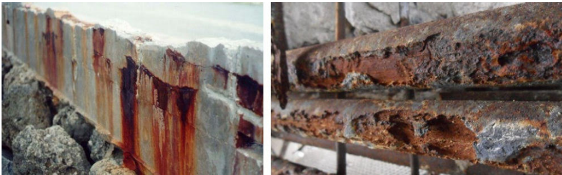
Slika 1: Korozija armature [3]
