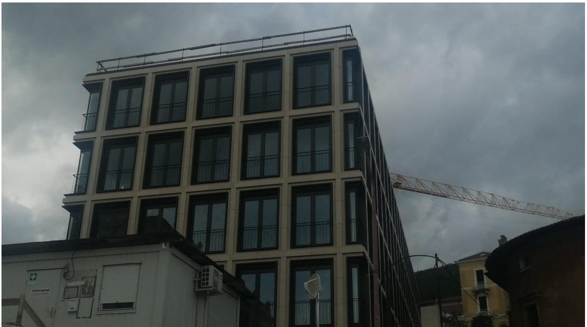
Slika 22: Hotel Keight u izgradnji (foto autor, 2023.)
