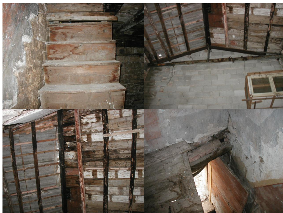
Slika 42: Postojeća drvena konstrukcija na predmetnoj građevini (osobna arhiva, 2022.)
