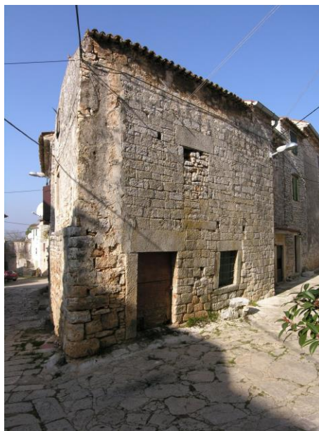
Slika 11: Južno pročelje građevine 141
