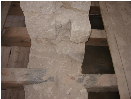
Slika 30: Oslonac drvenog grednika na kamenu zid (osobna arhiva, 2009.)
