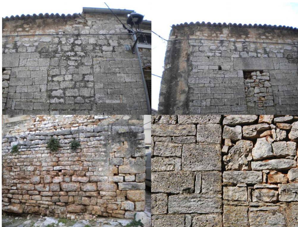
Slika 41: Postojeći zidovi na predmetnoj građevini (osobna arhiva, 2022.)
