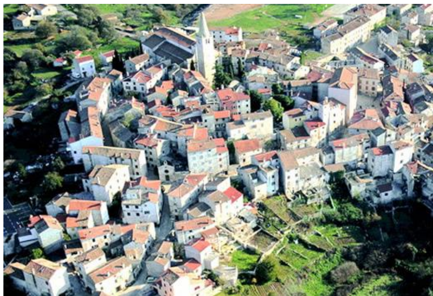
Slika 12: Kuće u povijesnoj jezgri Bala 150
