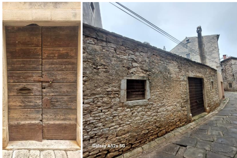
Slika 16: Ulazna i dvorišna vrata, Vodnjan (foto autorica, 2023.)
