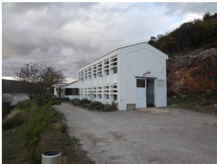
Slika 2.9. Današnja crpna stanica na Vranskom jezeru na Cresu (izradio autor)
