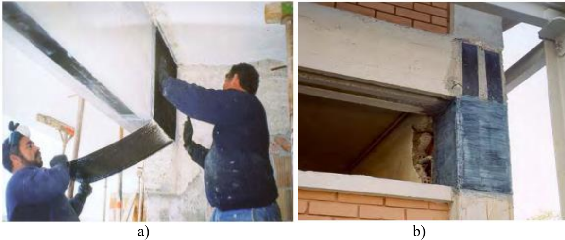
Slika 23: Posmično pojačanje: (a) kraj grede; (b) kratki stup [1]
