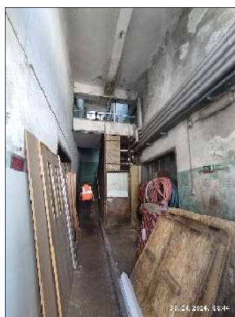
Slika 43: Unutrašnjost prema današnjoj stolarskoj radioni (oznaka "4") (foto autor, 2024.)
