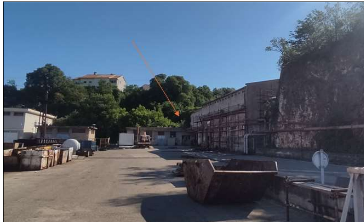
Slika 21: Konačna lokacija brodograđevne škole (foto autor, 2024.)
