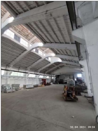
Slika 44: Unutrašnjost brodograđevne radione (oznake "11a") (foto autor, 2024.)
