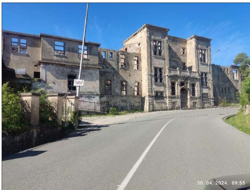
Slika 4: Prilaz ex hotelu Liburnija sa sjeverne strane (foto autor, 2024.)
