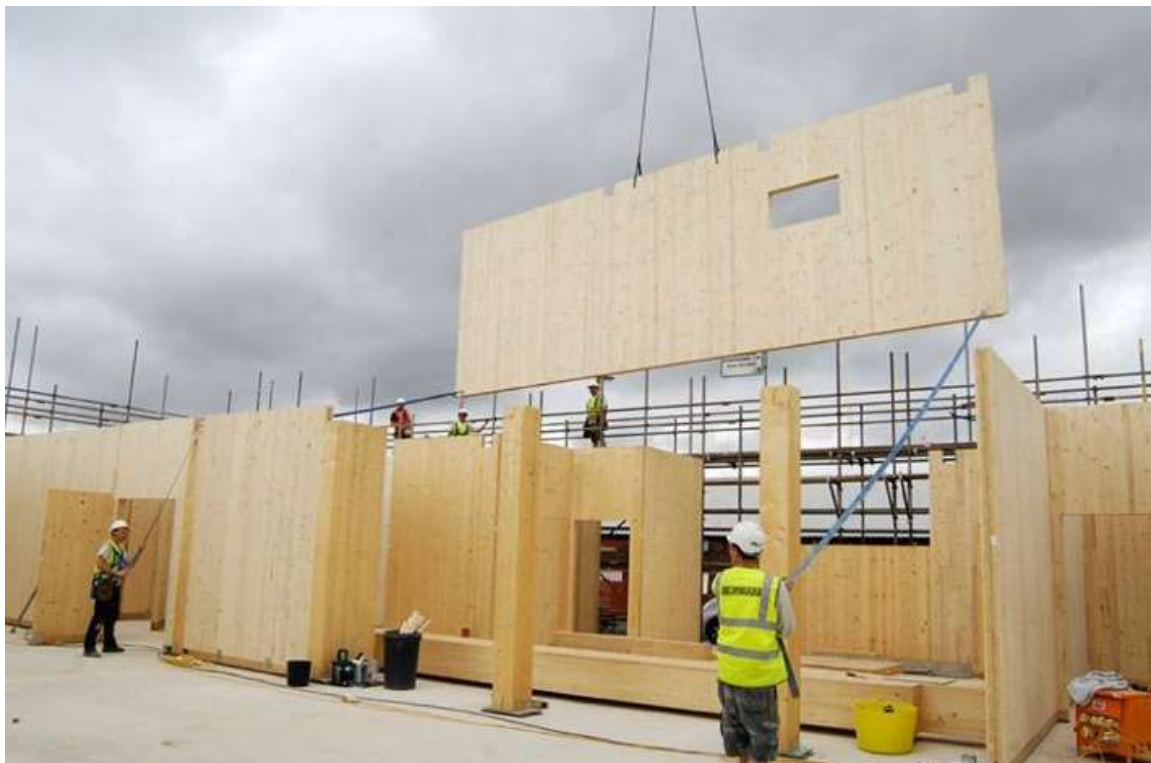
Slika 6: Montaža CLT elemenata (izvor: https://drvotehnika.info/clanci/razvoj-unakrsno-lepljenog-drвета-clt-panela , 26.05.2024.)
