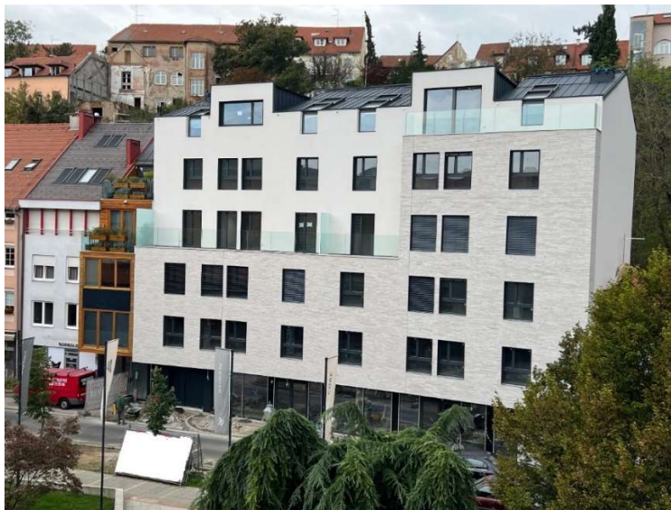
Slika 9: CLT zgrada u Zagrebu (izvor: https://tkalciceva.com/hr/#odlike , 26.05.2024.)
